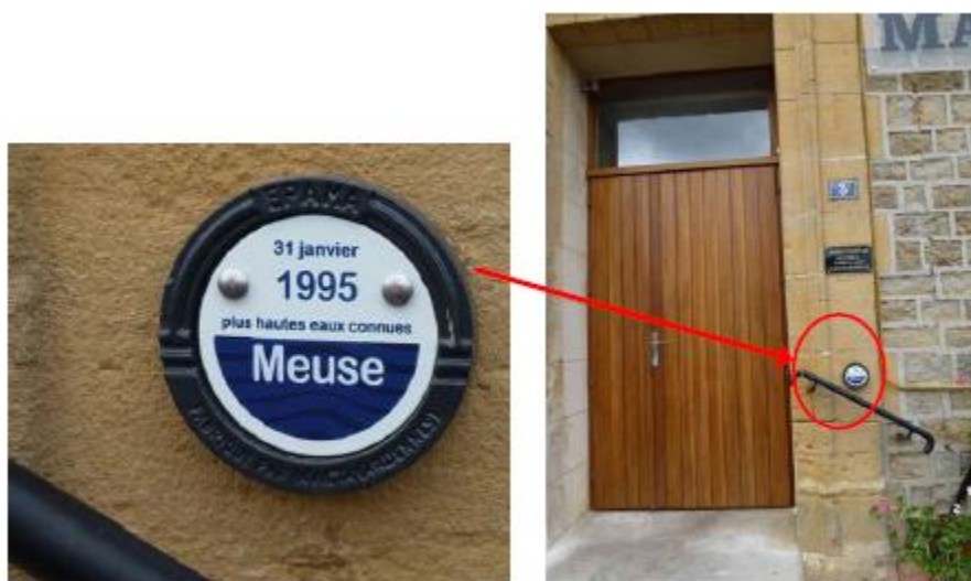
Repères de crues, Mairie de Warcq (08)
