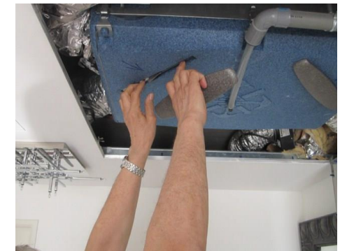
Luftfilterwechsel in einer Wohnung mit Niedrigenergiestandard
