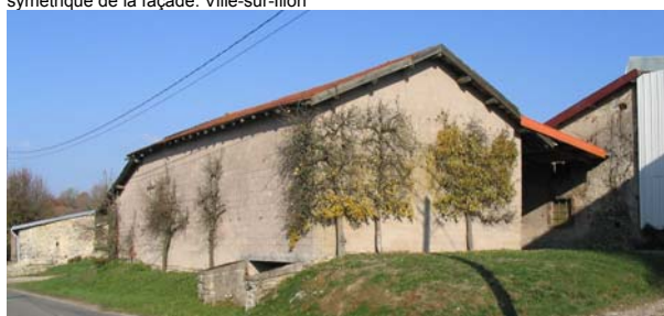
Les fruitiers peuvent aussi animer une façade aveugle d'un bâtiment agricole. Les Ableuvenettes
