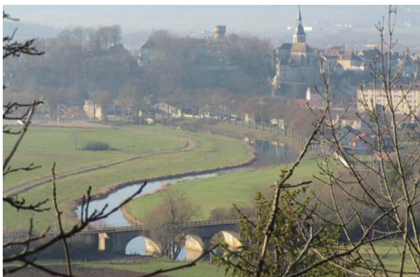
Le pont, aux abords dégagés, compose dans le paysage avec la silhouette du village et l'ensemble de la vallée. Neufchâteau
