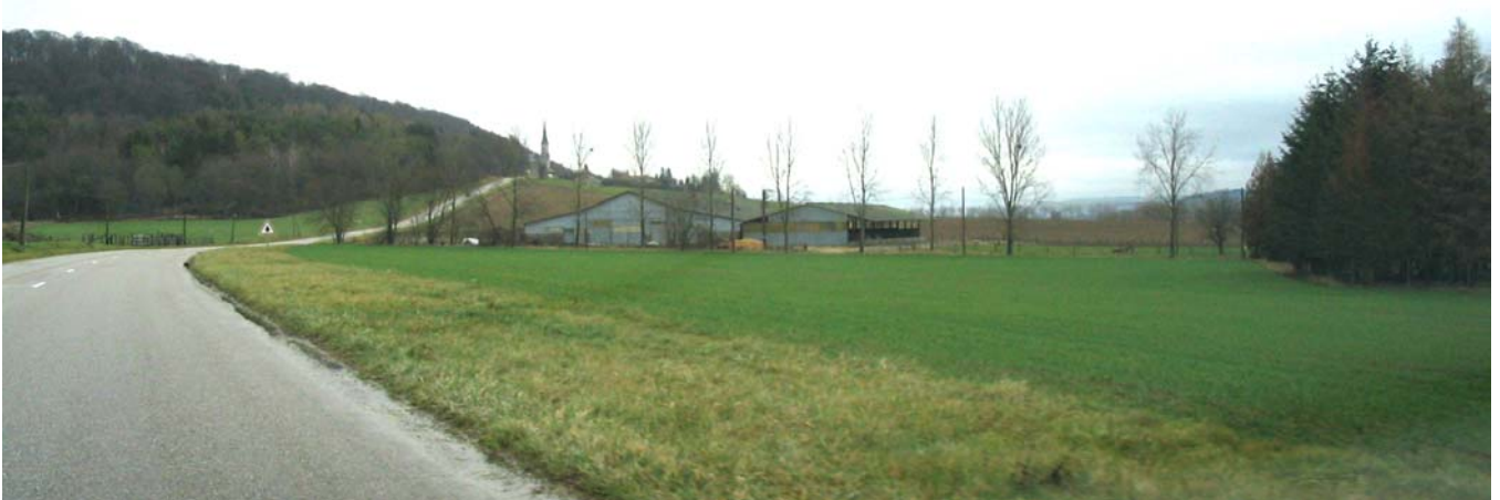
Bâtiment agricole en tôle au premier plan de l'accès à la basilique de Bois-Chenu : un plan de paysage pourrait être mis en place afin de valoriser les accès aux deux sites touristiques.
