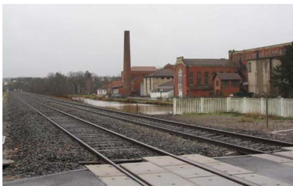
L'usine est généralement située entre la route, la voie de chemin de fer et la rivière. Vincey
