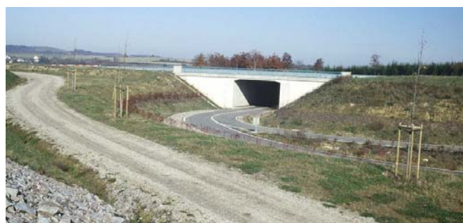
La qualité des terrassements et des plantations conditionne la réussite de l'insertion des échangeurs routiers. Bocquegney
