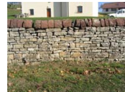
Le mur en pierre. Bégécourt
