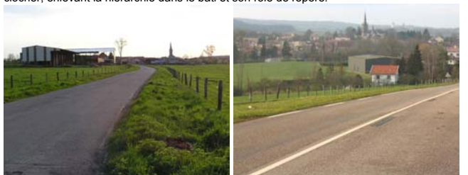
Maîtriser l'implantation des bâtiments d'activité dans les perspectives sur le clocher, en périphérie des bourgs et des villages.
