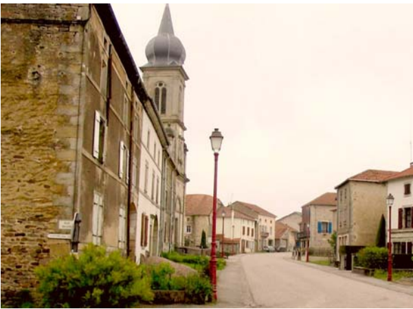
Les maisons n'étaient pas toutes jointives au départ. Cette rue secondaire, probablement plus tardive que la rue principale comporte des maisons isolées (sur la droite) dans le bourg par ailleurs très préservé de Gruey-les-Surance.
