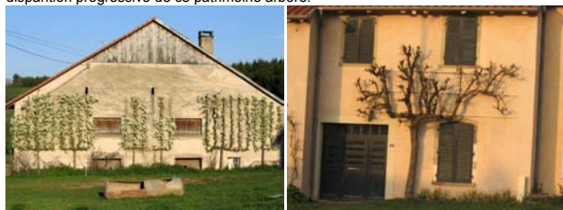
De nouvelles plantations de fruitiers palissés ou leur préservation le long de façade restaurée laissent entrevoir la pérennité d'un savoir faire.
