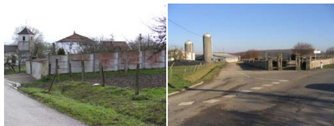
Veiller à la qualité des murs et à la maîtrise des terrains à proximité pour respecter la présence du cimetière.
