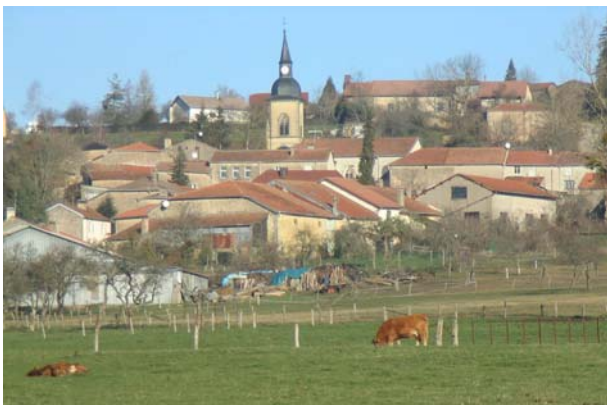
Des fermes imbriquées, groupées autour du clocher, dont les toits forment un épannelage ordonné typique des villages-rue lorrains. Beaufrémont
