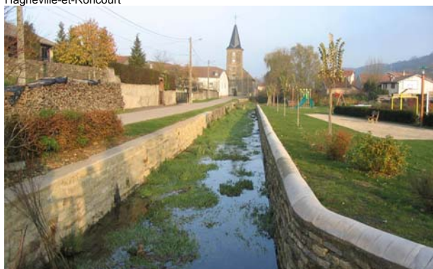
Le mur, constitue un élément de composition urbaine qui met en valeur les abords du cours d'eau et souligne la perspective sur l'église. Bainville-aux-Saules
