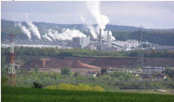
De vastes emprises industrielles en fond de vallée dont la présence reste très prégnante. Le Thillot
