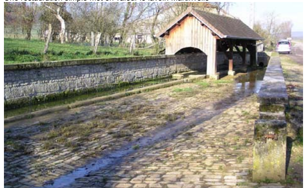
Un lavoir à ciel ouvert associé à une mare pour laver les chevaux de labours, auxquels a été ajouté un petit auvent en bois. Urville
