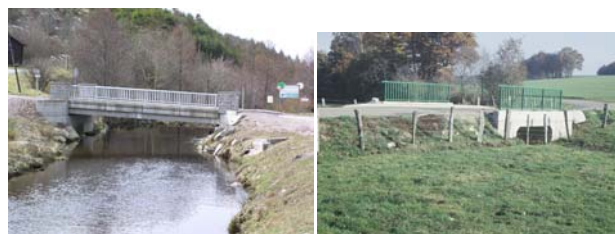
Maîtriser la qualité architecturale des ponts et l'aménagement de leurs abords.
