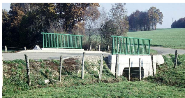
L'architecture des ouvrages et leur raccordement au terrain existant (terrassement) sont des points à ne pas négliger. Mazelay
