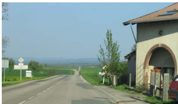
La structure traditionnelle du village rue reste perceptible en l'absence de nouvelles constructions. Moyemont
