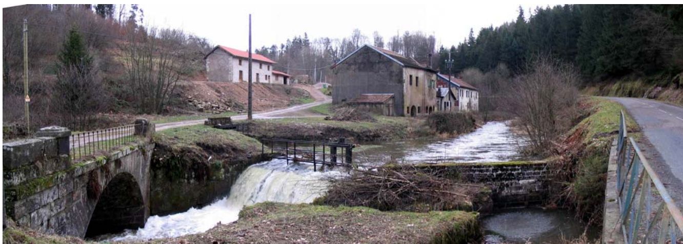
Toute l'activité de la vallée s'est longtemps organisée autour d'un cours d'eau aménagé pour faciliter la navigation, la pêche, et plus tard le flottage du bois, l'alimentation de roues à aubes ou à augets. Bellefontaine.
