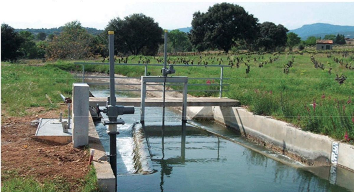
Exemple de système de régulation de la surverse (d'après pièce D de l'étude d'impact)
