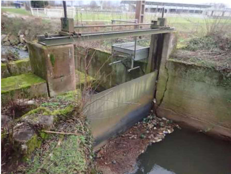
Figure 7 : Vannage du bras de décharge du moulin
