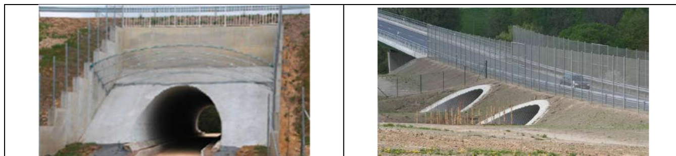
Illustrations de grillages de protection pour les chauves-souris (CEREMA, 2016), à gauche type cage de football avec grillage orienté vers l'entrée de l'ouvrage, à droite au droit de la route avec grillage
