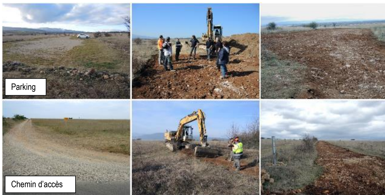
Travaux de phase 2. DIETRICH L. / CSA
