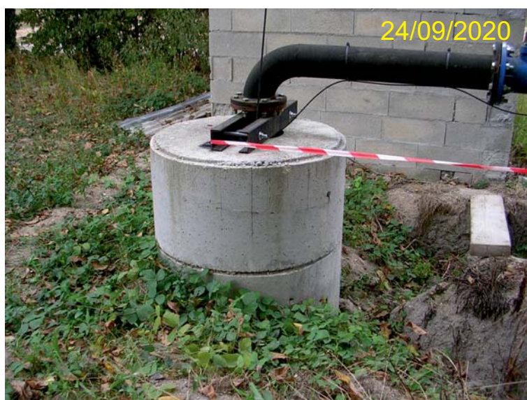
2. Vue rapprochée du site d'implantation
