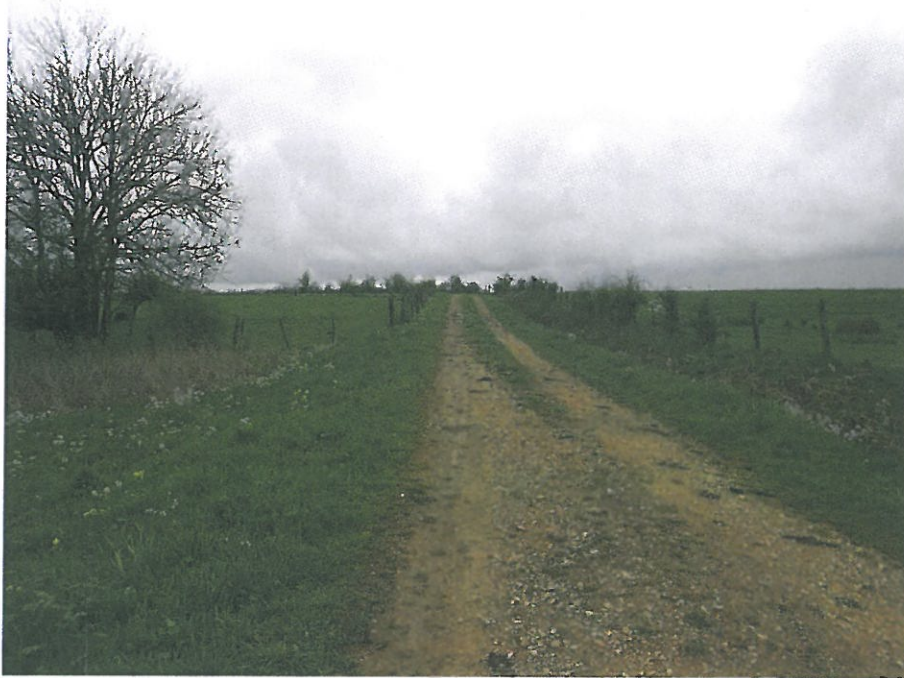
Photo 1 : 20 avril 2015 : Vue depuis début du chemin (depuis RD – zone à mettre au gabarit)
