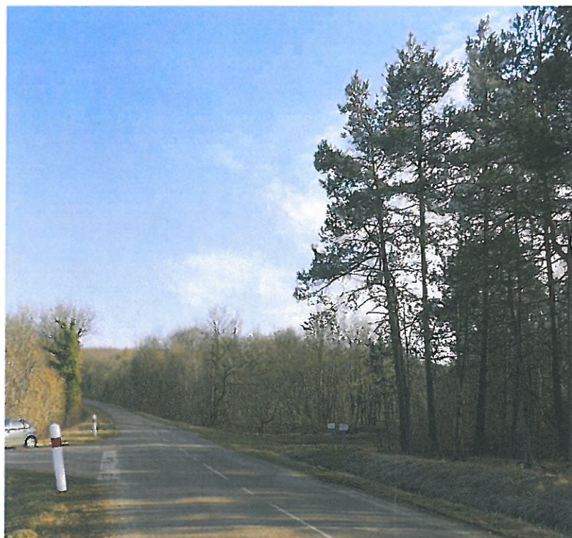
Photo 3– Mars 2015 – Début projet côté RD20 (accès à créer)
