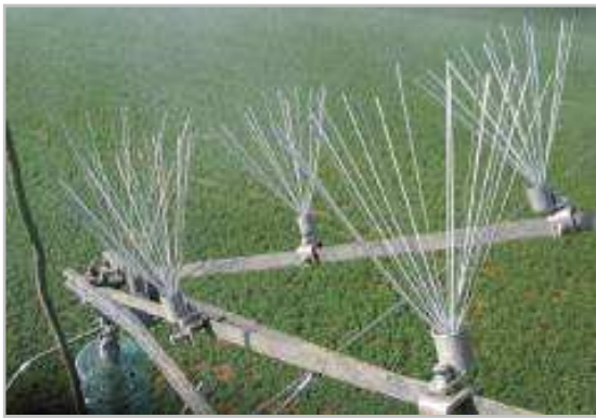
Figure 19 : dispositif « parapluie » empêchant l'installation de nids sur les lignes HT (source : audeladelines.com )
