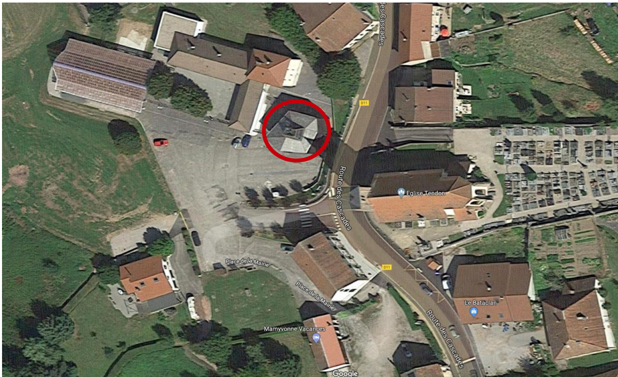
Figure 1 : Vue aérienne du groupe périscolaire (source : Google Maps)
