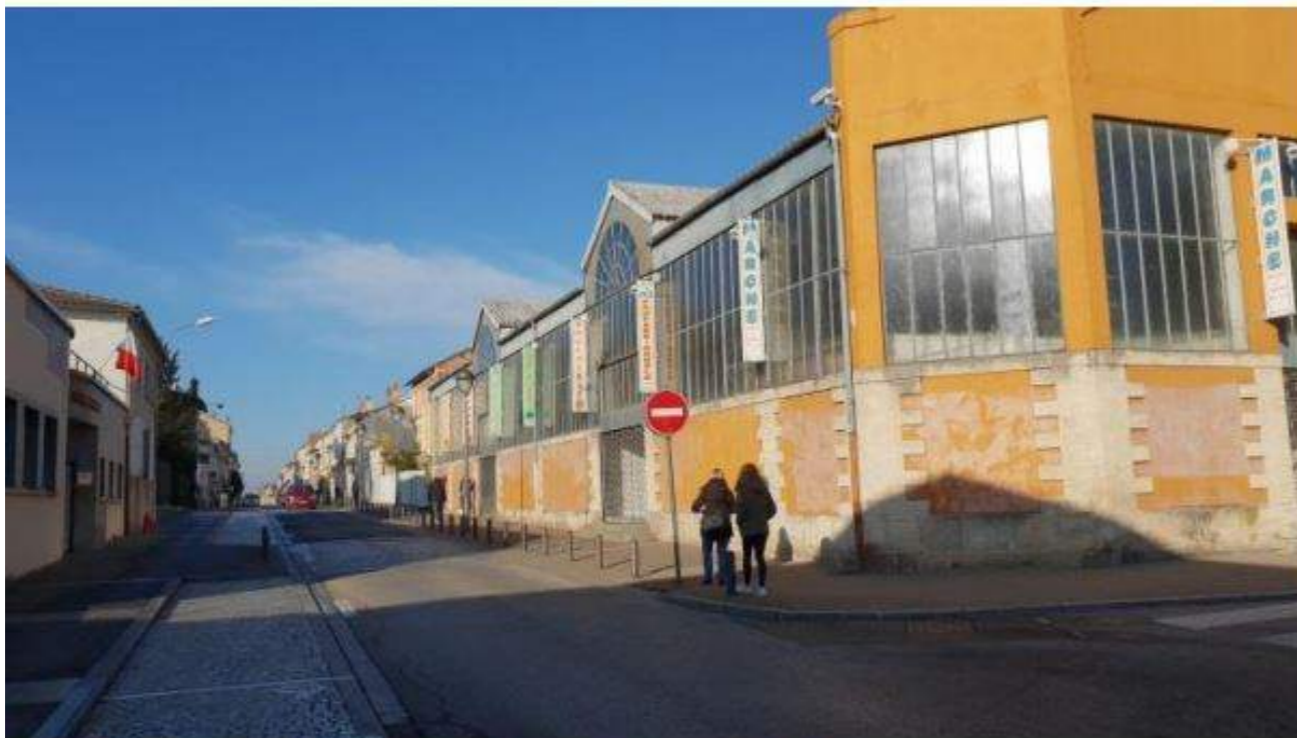
Photographie de l'existant extérieur - Façade Sud - Est
