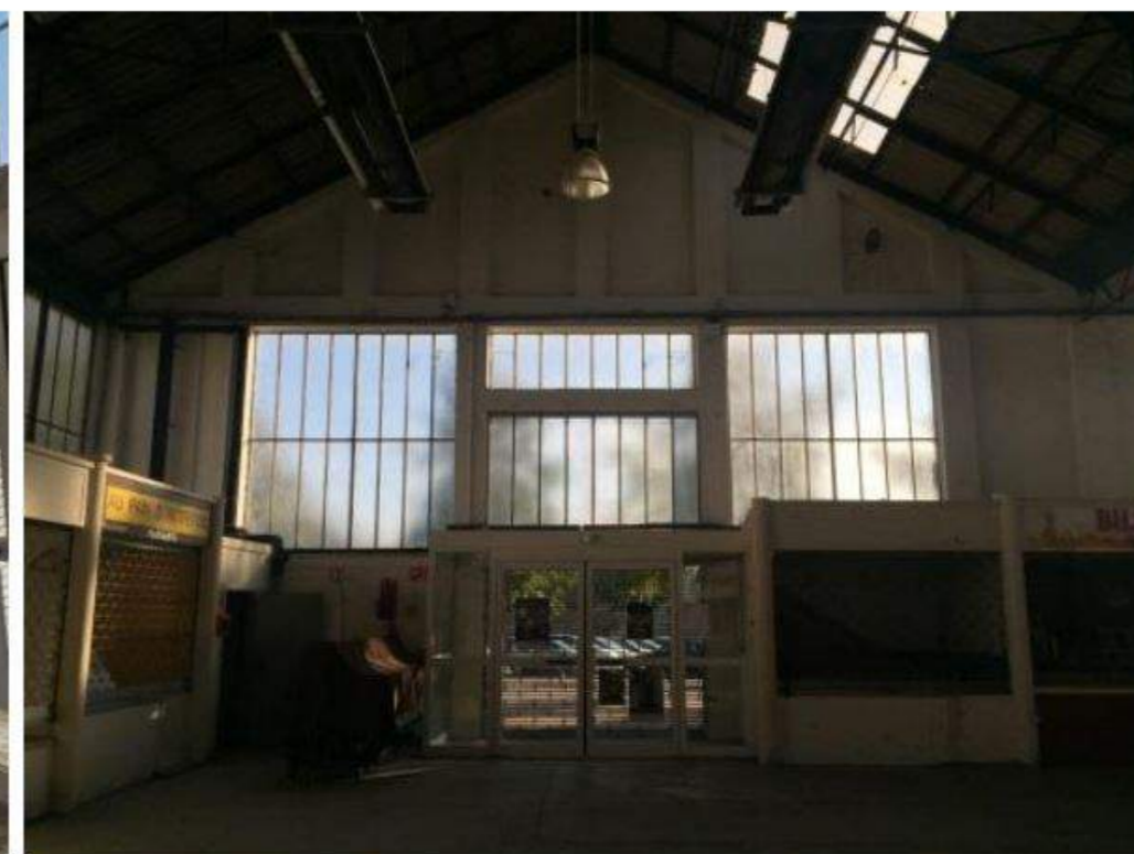
Photographie de l'existant vue intérieure - Façade Est
