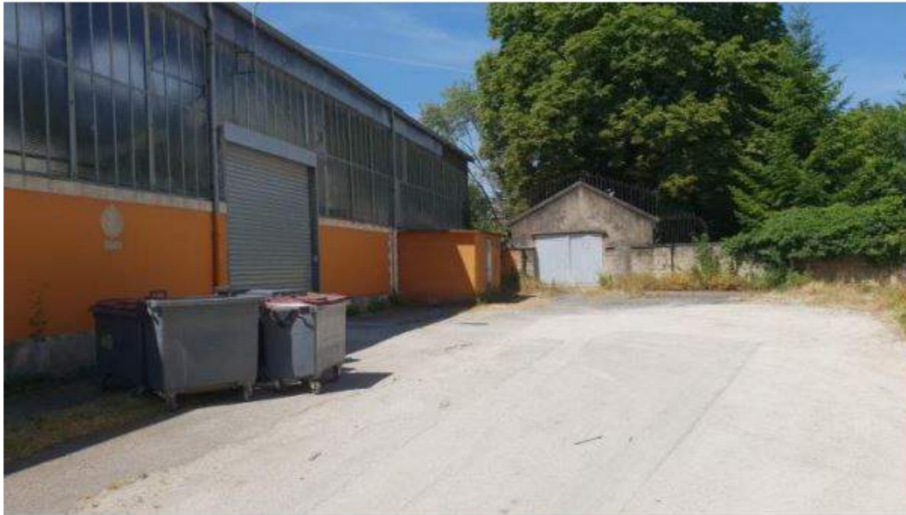
Photographie de l'existant extérieur - Façade Nord
