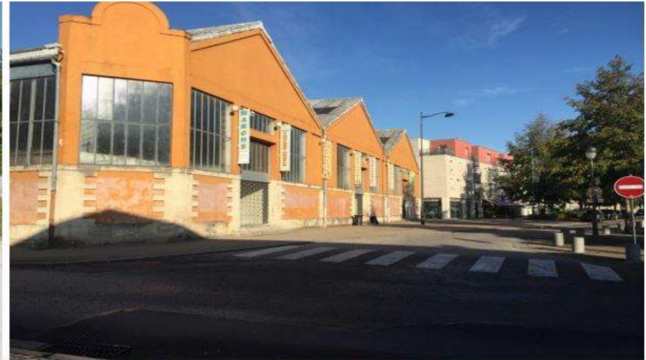
Photographie de l'existant extérieur - Façade Est
