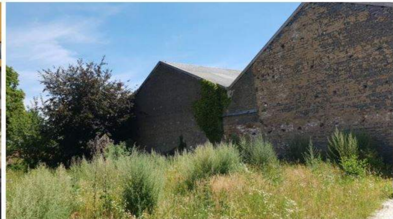
Photographie de l'existant extérieur - Façade Ouest
