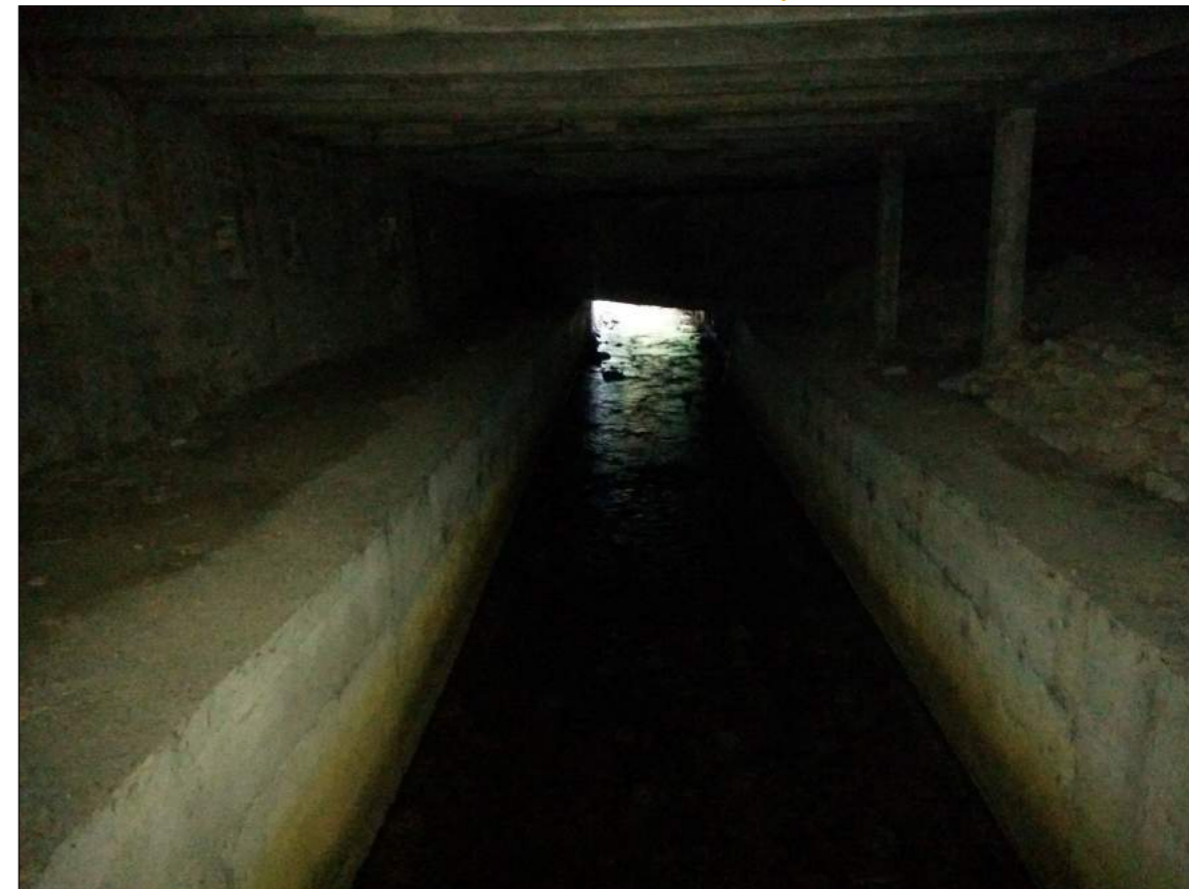
Illustration 20 : Ornel et entrée nord/ouest depuis l'intérieur
