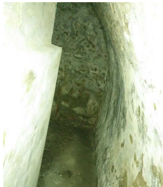
Illustration 3 : photo de l'intérieur de l'aération
