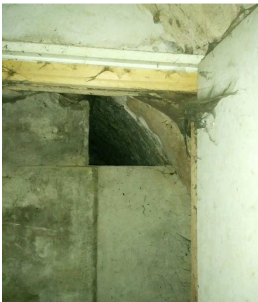
Illustration 2 : vue sur l'aération du compartiment 18 au 20
