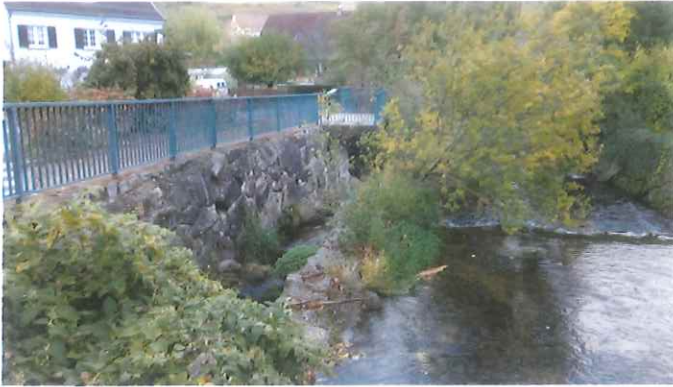
Passé à poissons et enrochements en RG
