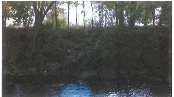
Enrochements présents en berge
