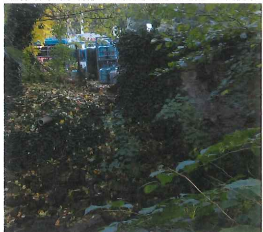
Enrochements et mur en RD amont : fin de la reprise des berges
