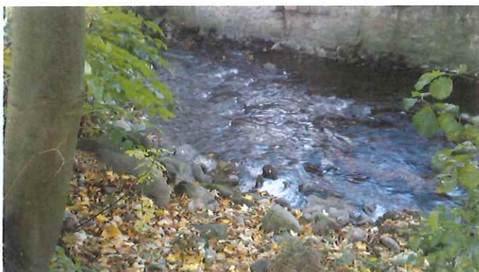
Protections de berges existantes en RG amont
