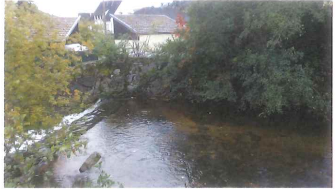
Enrochement en RD du seuil
