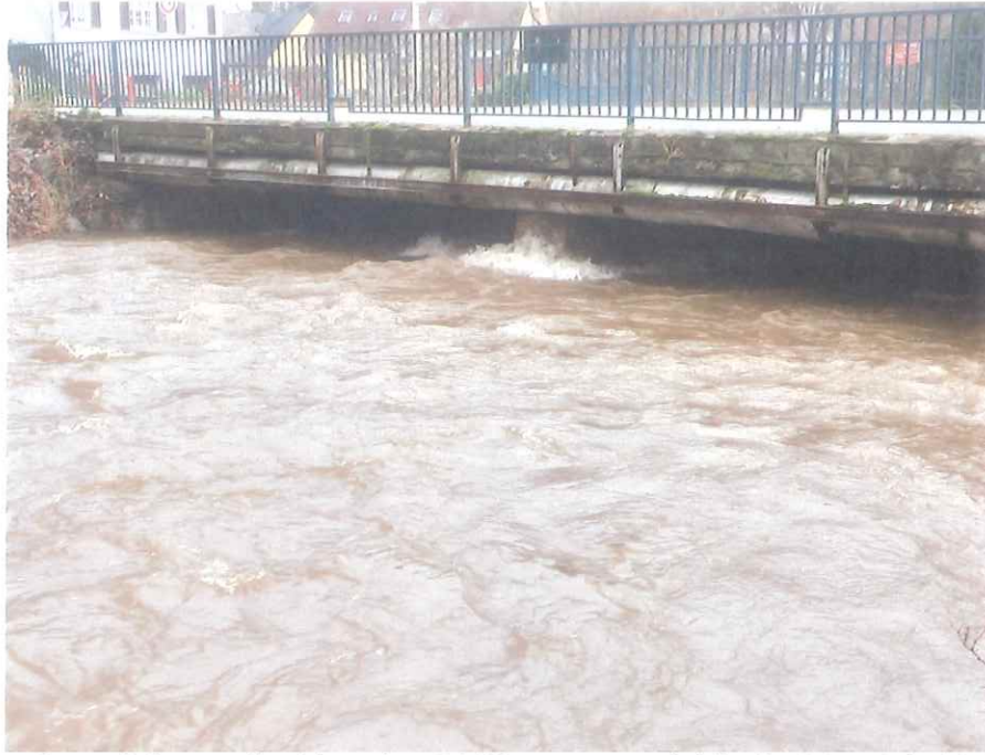
Amont du pont du Geisbourg le 5 janvier 2018 pour un débit de 20 m 3 /s (Q100 = 90 m 3 /s)
