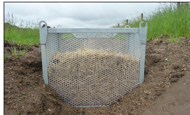
Photo 4 : Exemple de filtre à mettre en place - Filtre à paille – Modul'AP ® (Source : Eiffage)
