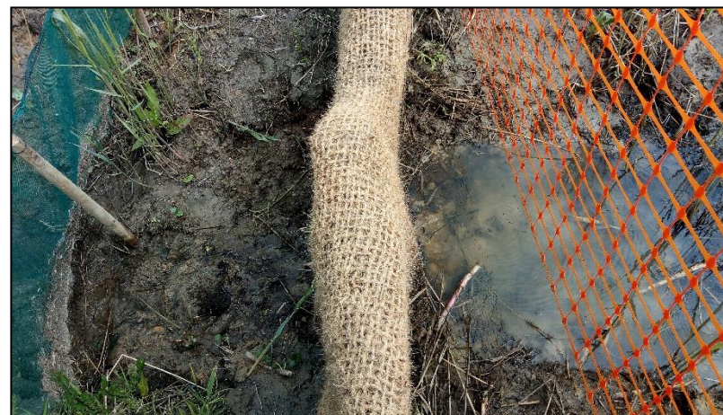
Photo 25 : Écoulement des lixiviats de droite à gauche (à droite, eau chargée en MES, à gauche, eau claire, filtrée) (Rainette)
