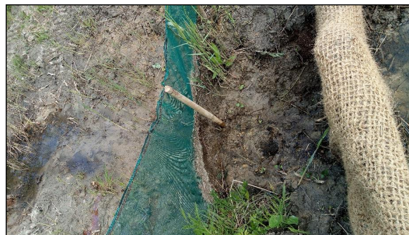
Photo 26 : Eau claire après le filtre (Rainette)
