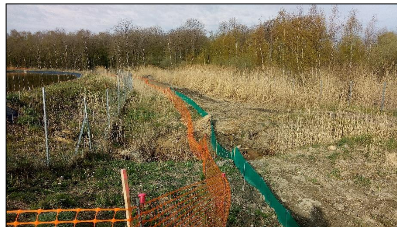
Photo 7 : Barrière de balisage haute visibilité garantissant l'emprise des travaux au niveau du bassin de rétention des lixiviats (Rainette)
