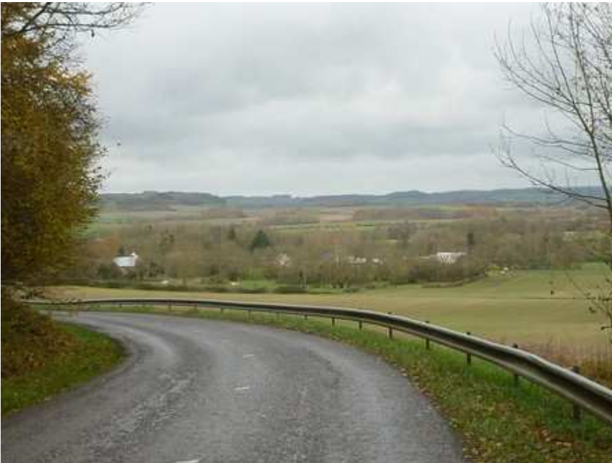
La RD14 au niveau du col entre le Mont du Châpeau et l'Épinette.
