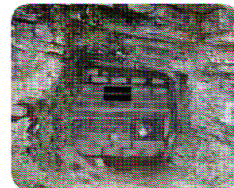
L'édification du mur est terminée. Le passage pour les chauves-souris mesure 70 cm de long pour 45 de haut. Un barreau est positionné au milieu. Un enduit au ciment avec une teinte proche de celle de la roche peut être réalisé afin de mieux intégrer l'ouvrage à son environnement.
