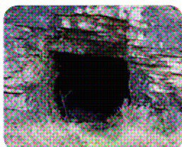
Il s'agit d'une galerie d'une quinzaine de mètres de longueur. Il a été décidé d'en réduire au maximum l'ouverture afin d'y obtenir, en période hivernale, une température plus élevée et plus constante.
