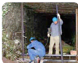
Mise en place du barreaudage intérieur. Les montants verticaux sont en fer UPN 80 mm, les montants horizontaux, en fer UPN 60 mm.
