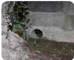
Intégration d'un passage pour la petite faune (micro-mammifères et batraciens), au ras du sol. Ce passage peut également permettre un écoulement de l'eau vers la cavité, favorisant ainsi une plus forte humidité.
