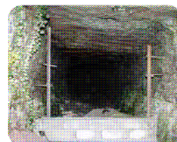
Édification du mur en parpaings pleins contre la grille.
