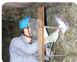
Fixation des points d'arrimage des montants de la grille dans la roche.
