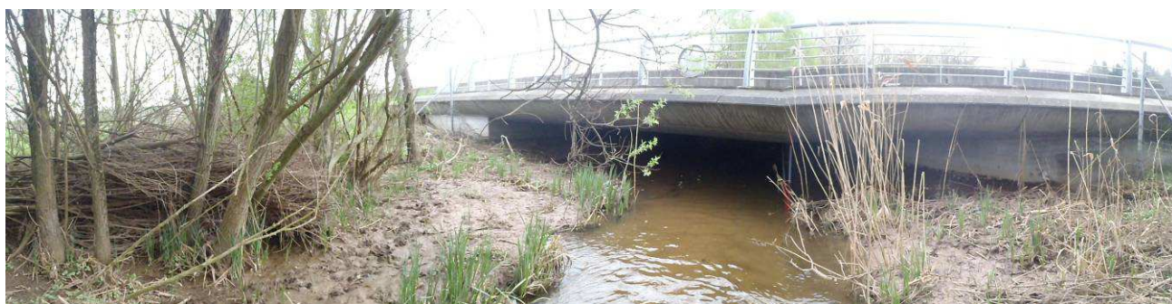
Le pont de la VRPV vue de l'amont vers l'aval.
