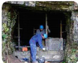
Intégration de la trappe d'accès pour les visites de contrôle. Cette trappe est soudée directement aux montants de la grille.
