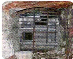
Vue intérieure de l'aménagement. L'ouverture pour les chauves-souris est située dans le troisième quart de la partie haute du mur (pas contre le plafond). Cette disposition permet de conserver l'air plus chaud dans la partie haute de la cavité.
