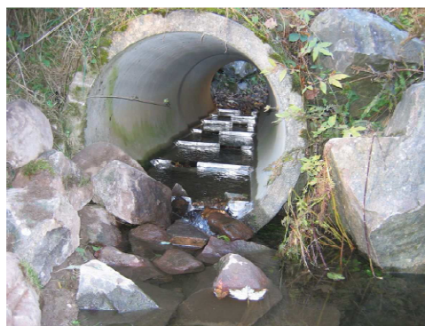
Seuils une fois mis en place dans la buse
