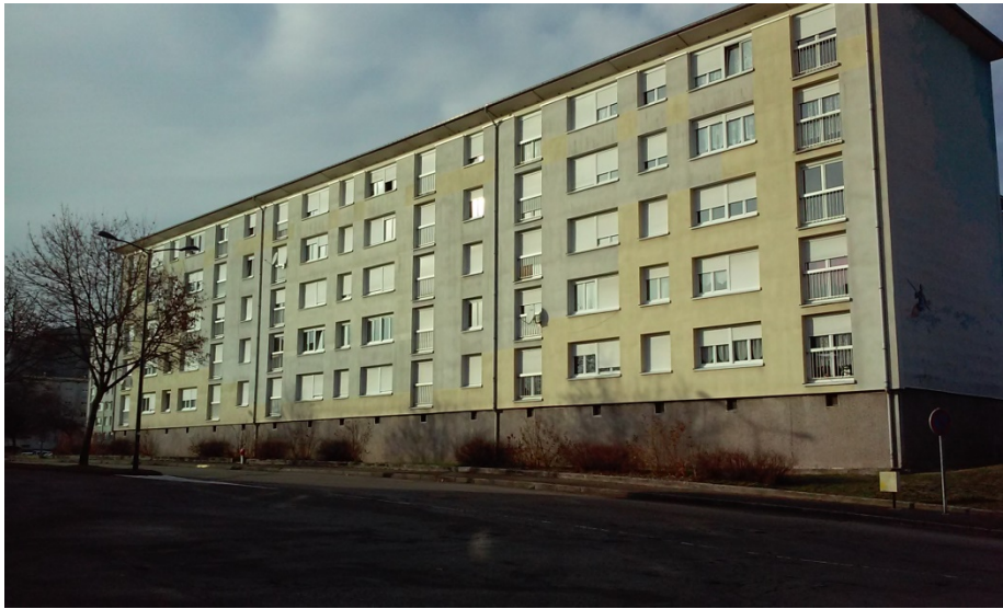
2 – 6-8-10 rue de Bitola – Façade arrière sur rue David Maigret
