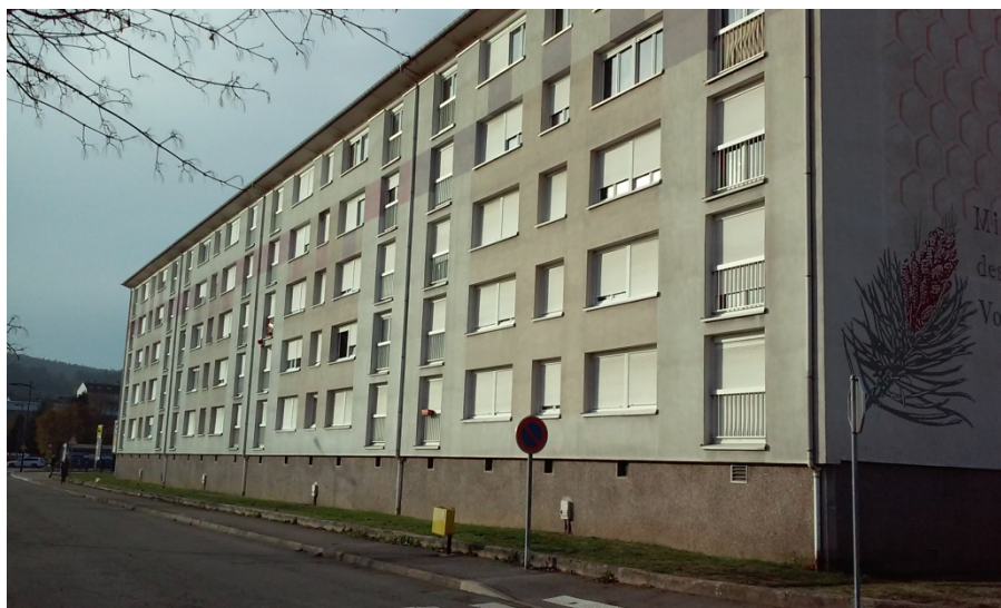
4 – 1,3,5,7 rue de Bitola – Façade arrière sur rue David Maigret
