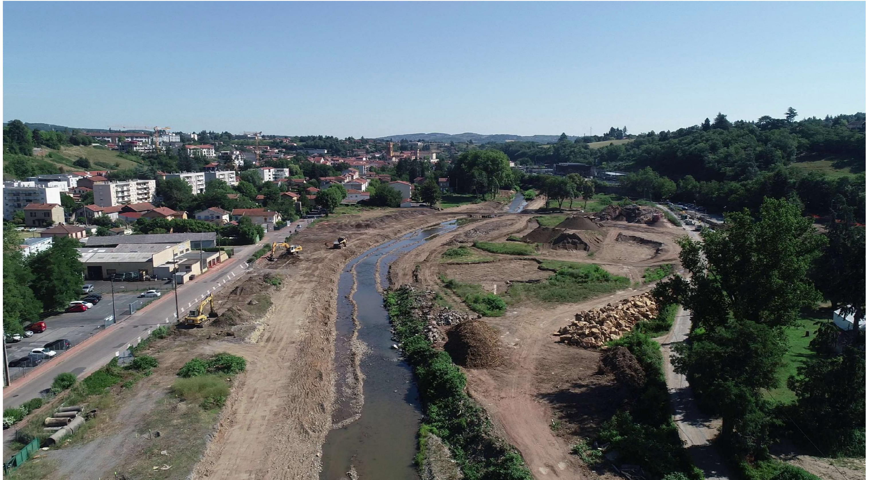
> le site - chantier en cours (septembre 2018)
