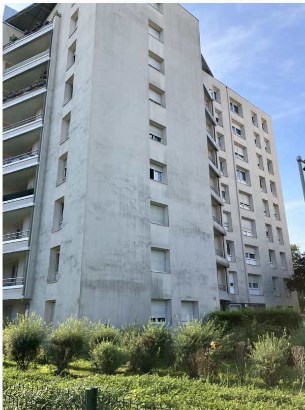
Illustration 13 : Vue des façades du bâtiment n°42 rue Wattwiller - Source ARCHIMED Environnement
