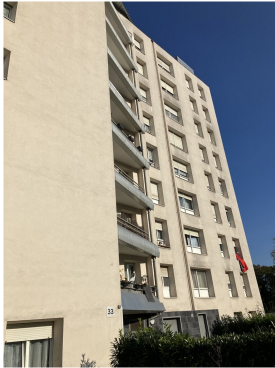
Illustration 12 : Vue de la façade n°33 rue Ampère - Source ARCHIMED Environnement
