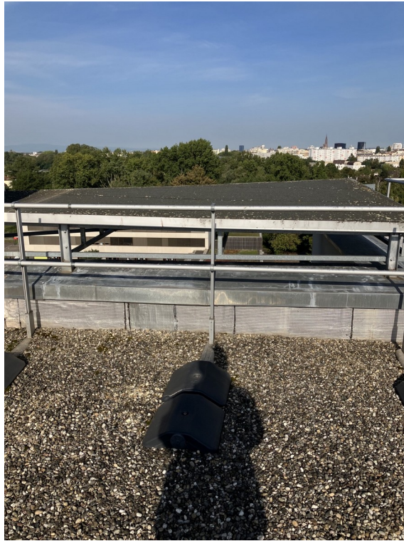
Illustration 15 : Gîte estival de la pipistrelle pygmée du bâtiment n°40 rue Wattwiller - Source ARCHIMED Environnement
