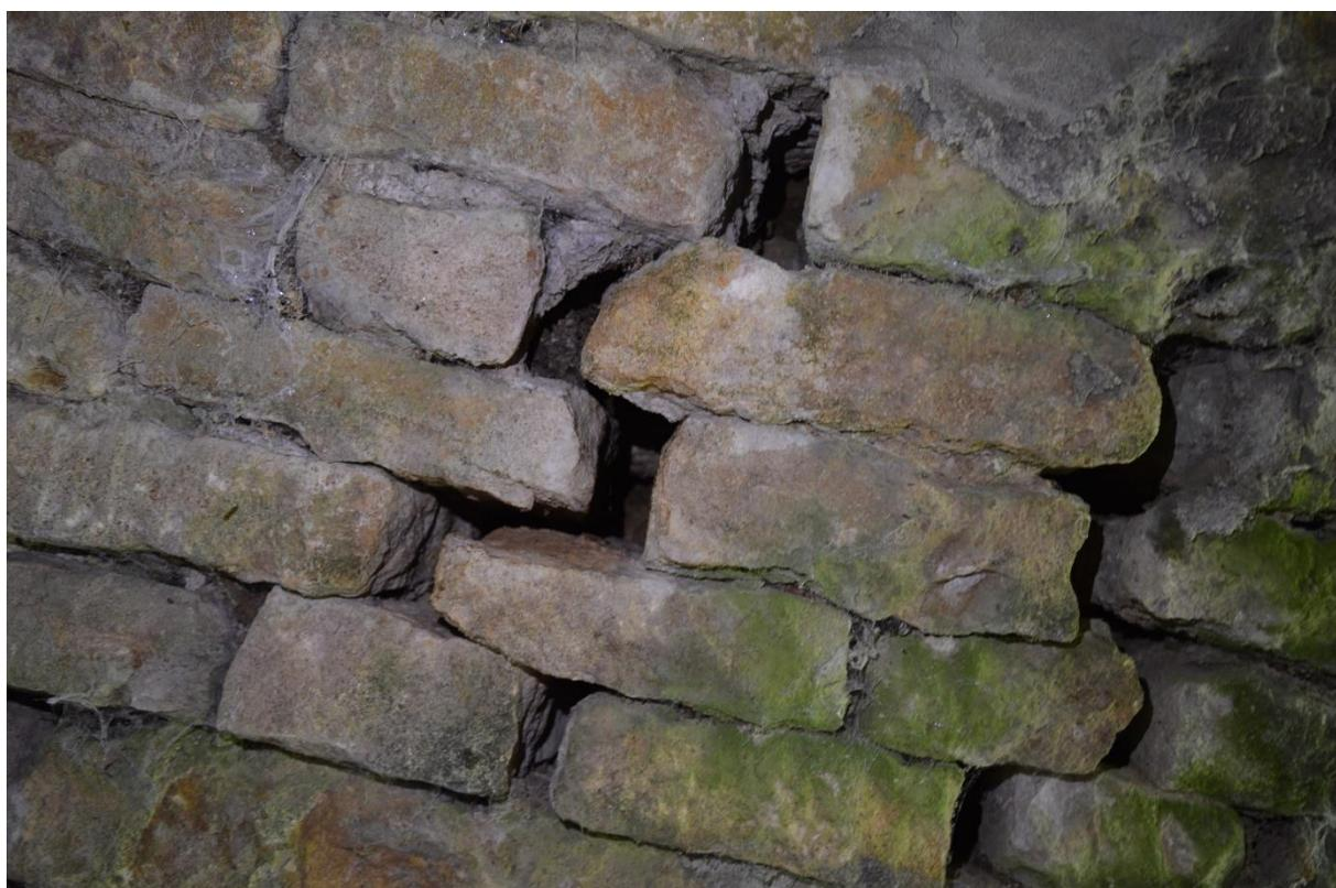
*Photo 3 : Vue détaillée sur une fissure*
