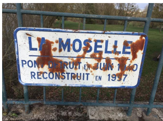
Figure 4. Panneau indicatif sur le pont.
