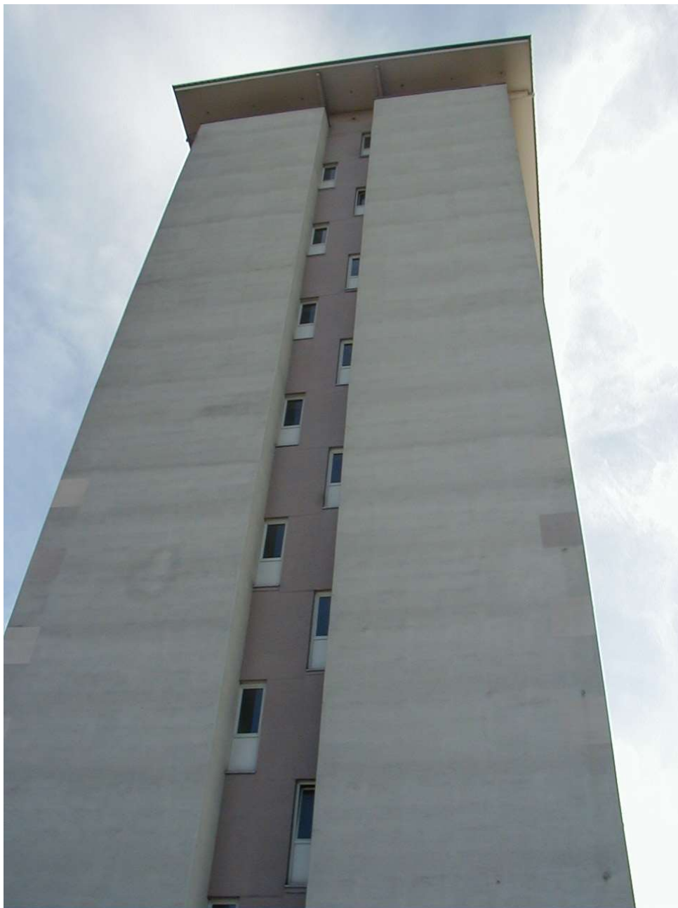
Une façade de la Tour du Champ du Pin destinée à être rénové ©Epinal Habitat
