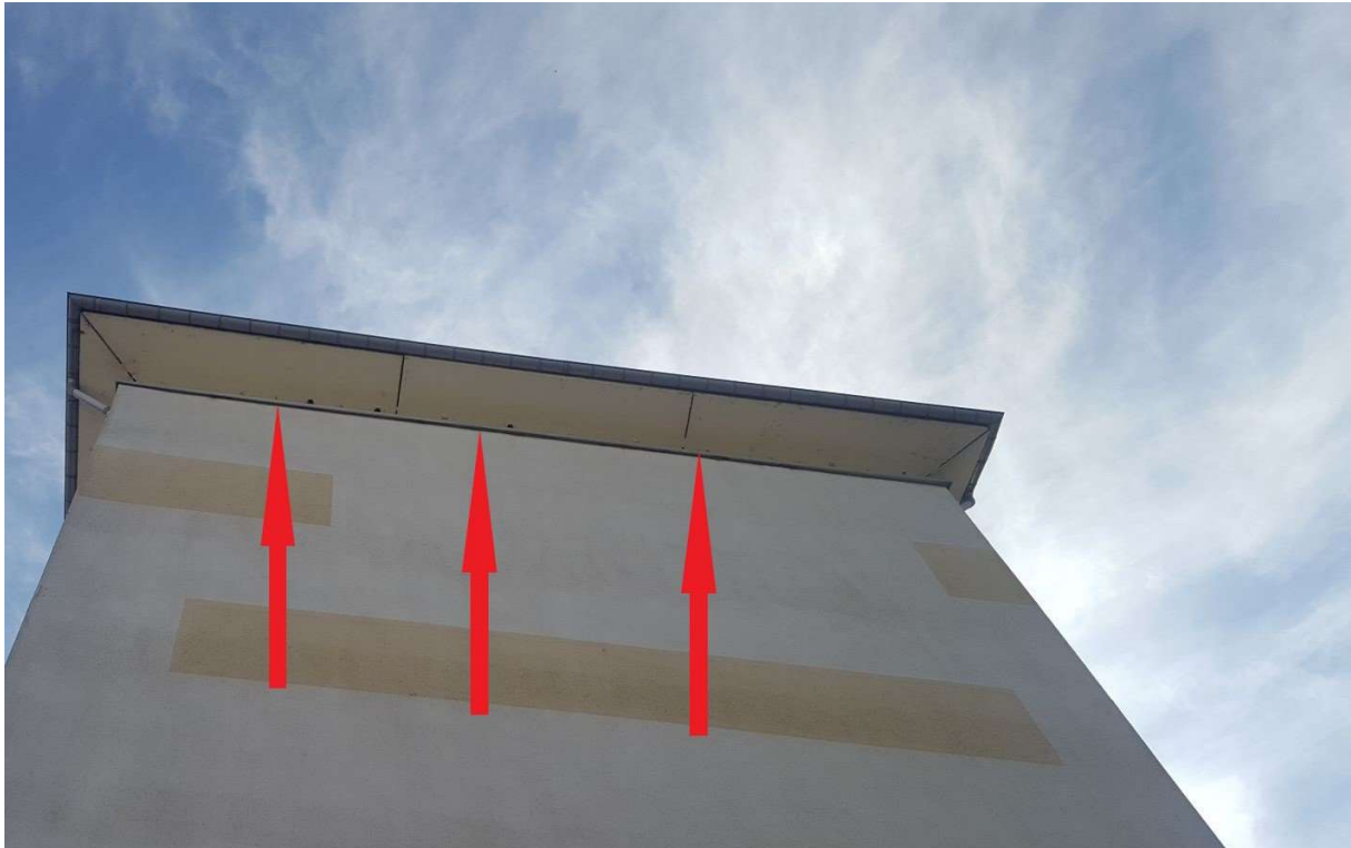
Une des façades occupées par plusieurs couples de Moineaux domestiques, rue de Bitola dans un bâtiment prochainement rasé. © N. Patier
