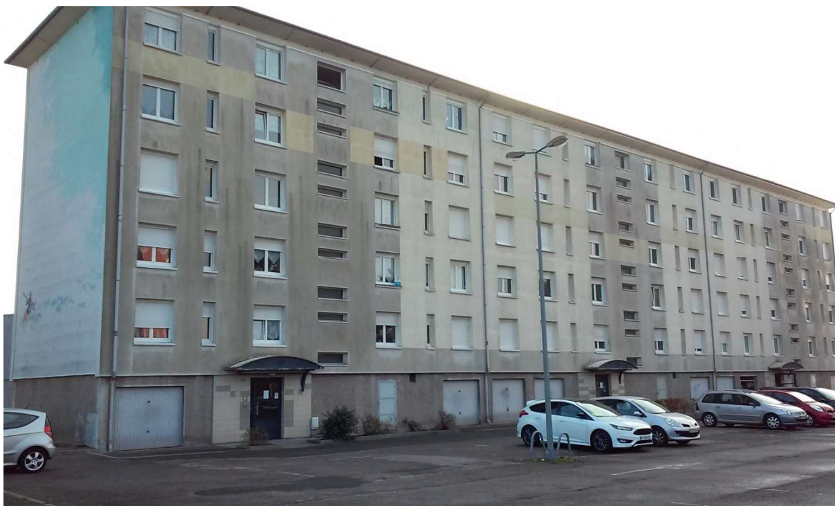
Un des bâtiments concernés par une destruction, rue de Bitola. ©Epinal Habitat
