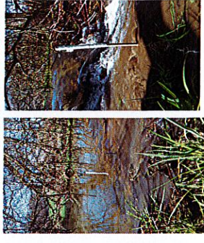
Barrage se trouvant dans la pâture Limite acceptable : -20cm du niveau actuel (soit niveau maximum de la berge côté aval du barrage)
