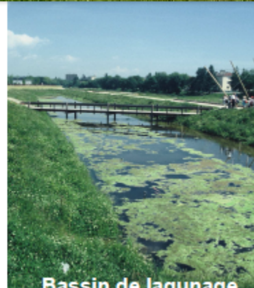
Bassin de lagunage
