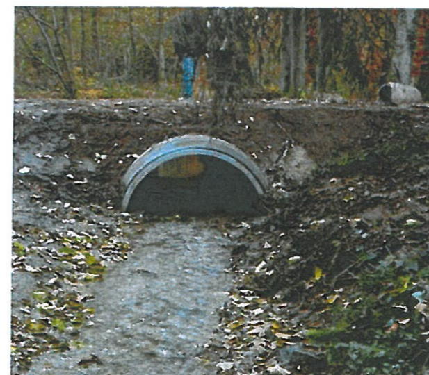
Photo 1 : passage d'un ruisseau sous une route à l'aide de demi-buses (Source ONF)
