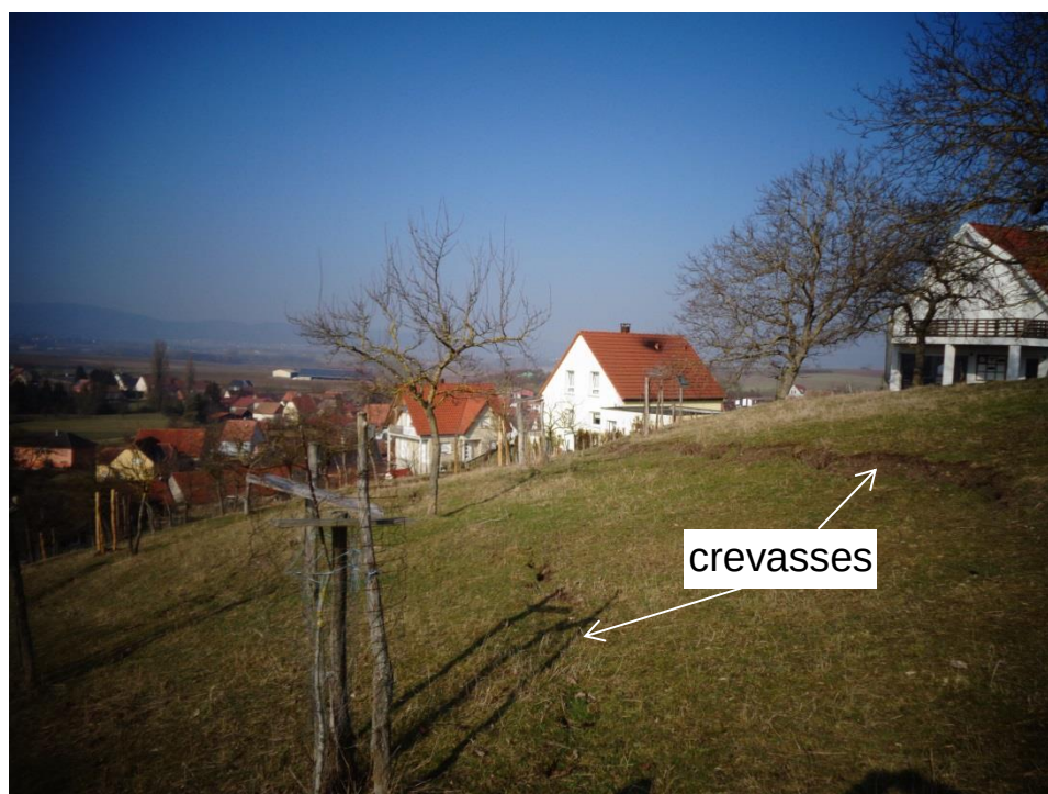
Situation des crevasses (photo prise le 14 février 2017)
