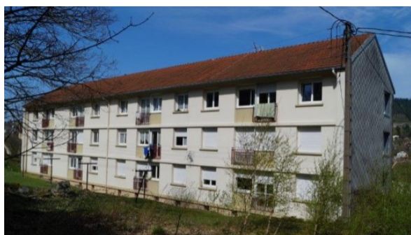
L'immeuble de 1967 avant travaux
