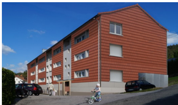
Perspectives du bâtiment après travaux
