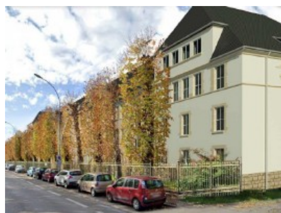
Projet d'écoquartier après travaux
