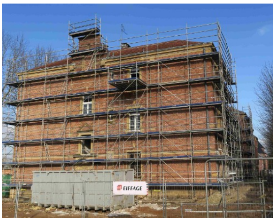
Réhabilitation en cours
