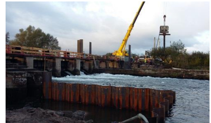
Restauration du barrage de la Steinsau : Protection contre les crues, passe à poisson, canoés, hydroélectricité
