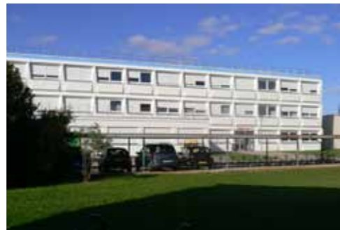
Bâtiments préfabriqués (1970-1980) Bâtiments A, B, C, D, E, Administration, SCD et restaurant universitaire
