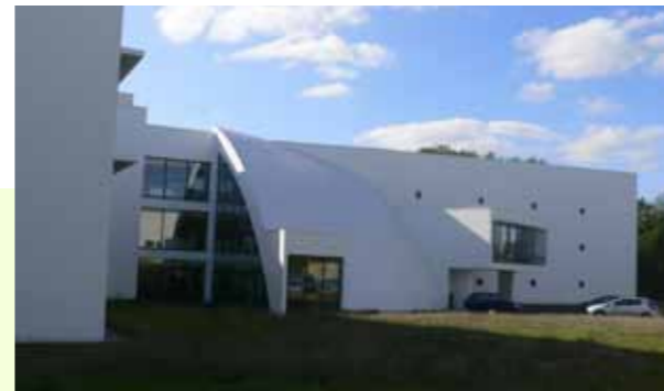
Bâtiments contemporains (1990-2000) Biopôle 1 et Halle de sport
