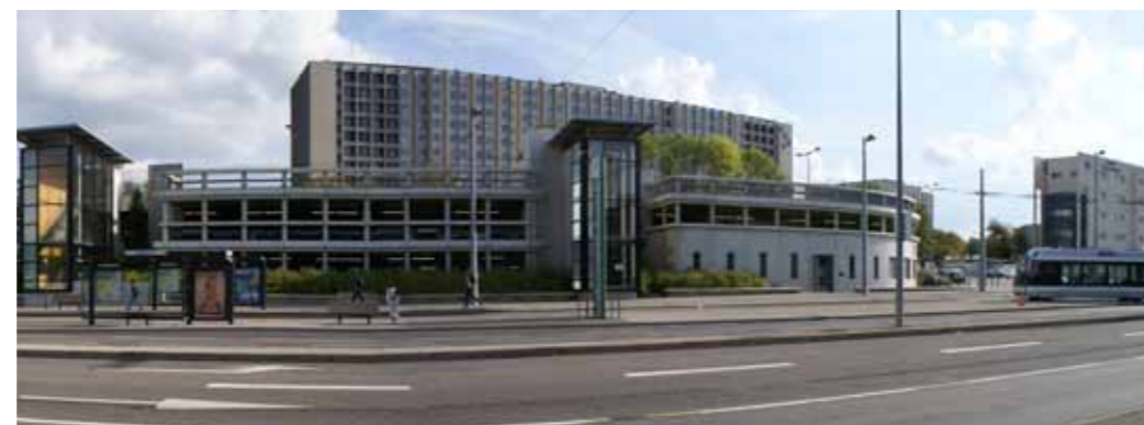
Le CHU est le seul signal paysager visible de loin sur l'entrée d'agglomération
