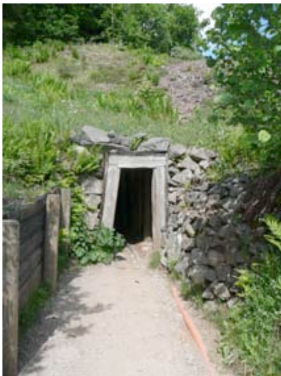
Figure 12 : L'entrée de mine visitable Saint Charles (TB -32)
