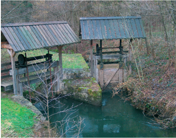
Vannes utilisées afin de réguler les niveaux de l'eau en période de crue.
