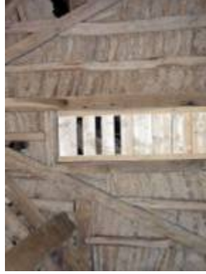
Une porte d'accès aux combles permettant le passage des chauves-souris.
