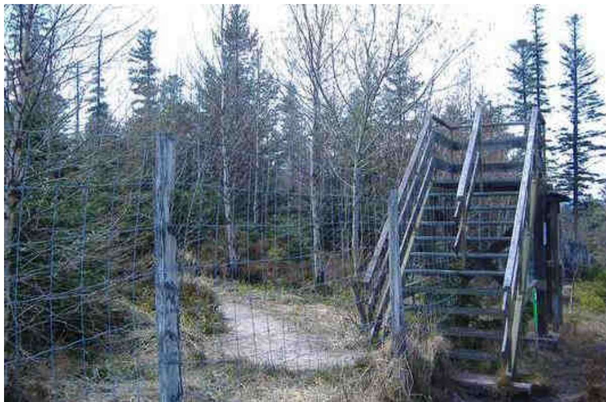
Cet ouvrage de franchissement d'un grillage sur sentier de randonnée permet de concilier préservation et fréquentation- Site de la Chatte pendue - Forêt domaniale du Donon. (© Eric DURAND / ONF).
