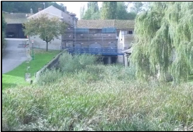
Photographie n° 1 : vue de la centrale existante
