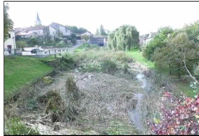
Photographie n° 2 : vue du canal de fuite avant pont
