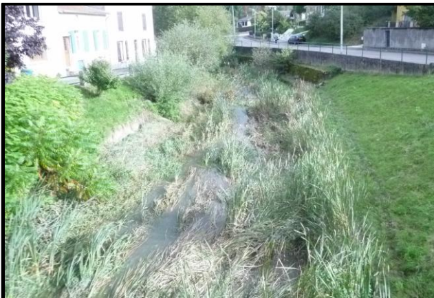
Photographie n° 3 : vue du canal de fuite après pont
