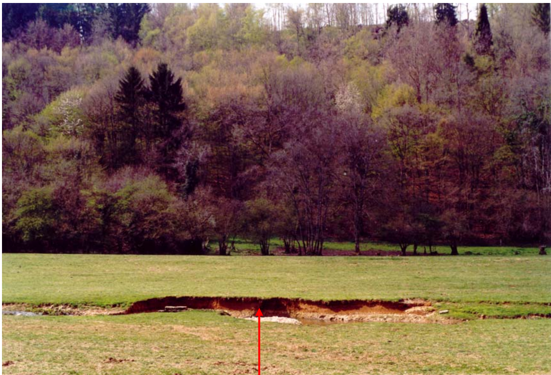
Erosion des berges
