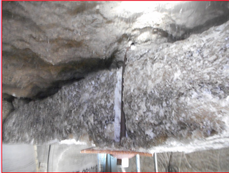
Verformte Gebirgsanker
