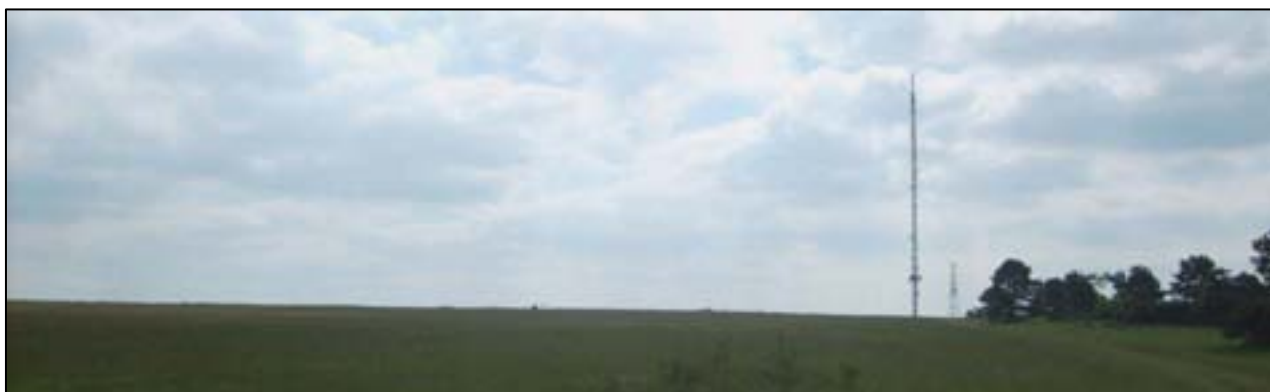
L'antenne TDF est visible sur le site comme à l'extérieur du site © Biotope, 2008 – photographie prise sur site –
