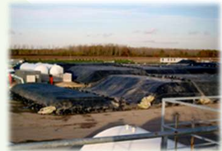
Traitement sur site (biotertres)
