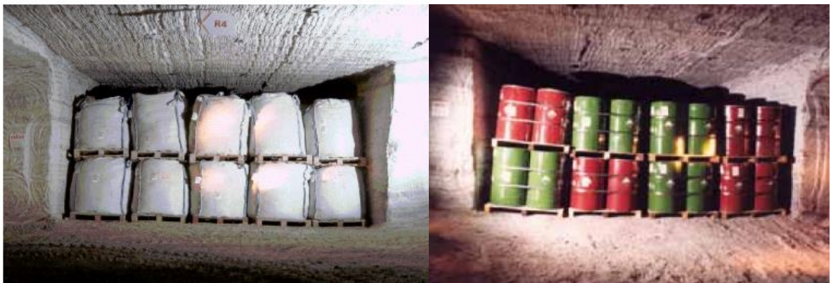
Figure 7. Exemple de bloc de déchet en big-bags et en fûts (MDPA)
