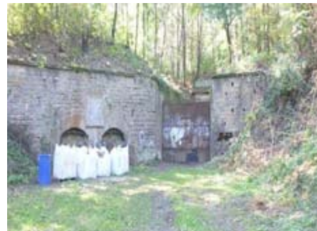
Figure 24 : Entrée principale du fort
