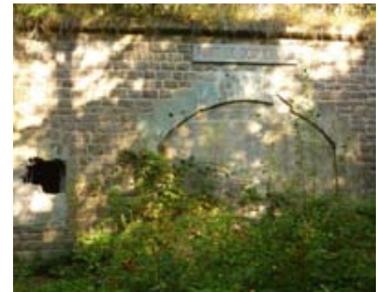
Figure 16 : Entrée murée du fort
