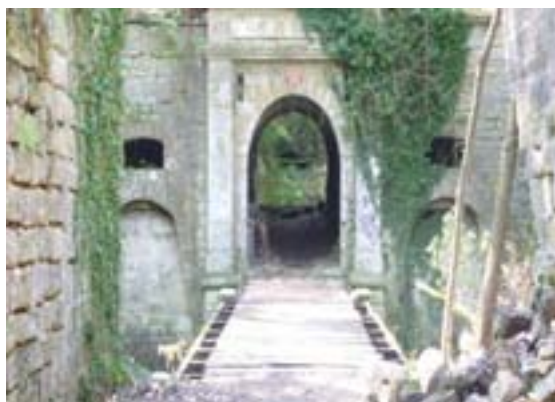
Figure 25 : Pont de l'entrée principale
