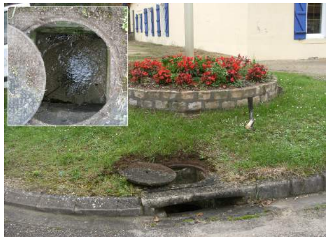
EAUX CLAIRES PARASITES RUE DE NACRILLON
