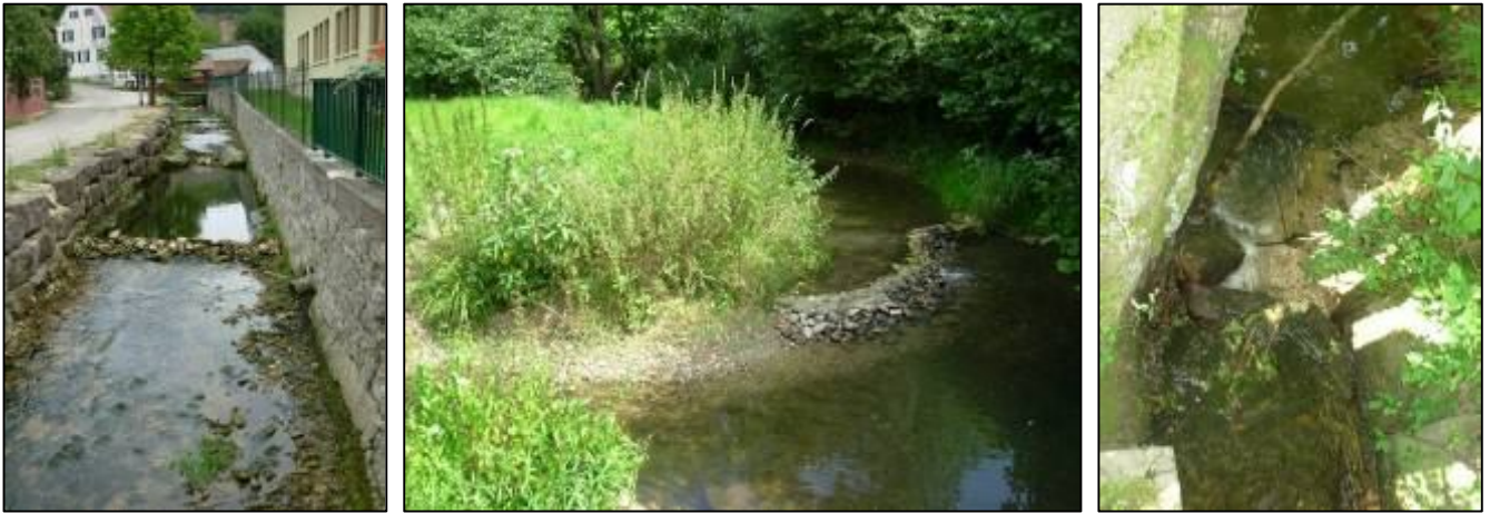
Bétonnage du Grumbach à Durlinsdorf, création de barrage pour alimenter le bétail sur le Largitzenbach et ancien barrage sur le Grumbach
