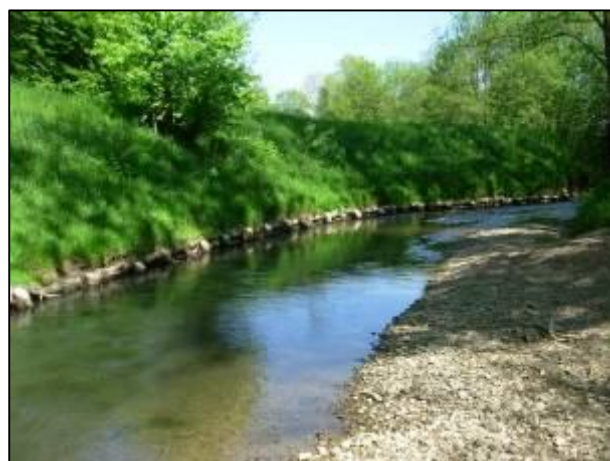
Maintien des berges par empierrement et mise en place de pieux de bois Photographies prises sur le site © BIOTOPE
