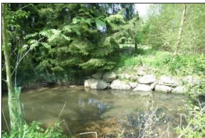
Maintien des berges par empierrement et mise en place de pieux de bois Photographies prises sur le site © BIOTOPE
