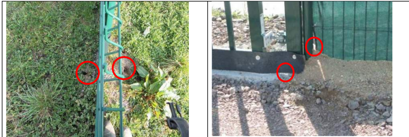
Exemples de singularités : trou de micromammifère communiquant de part et d’autre d’une clôture (gauche) et singularités au niveau d’un portail d’entrée (droite) – photos : R. D’agostino
