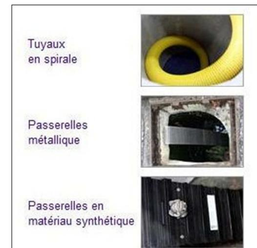
Figure 16 : Différents systèmes pour éviter les pièges pour la faune dans les structures collectrices
