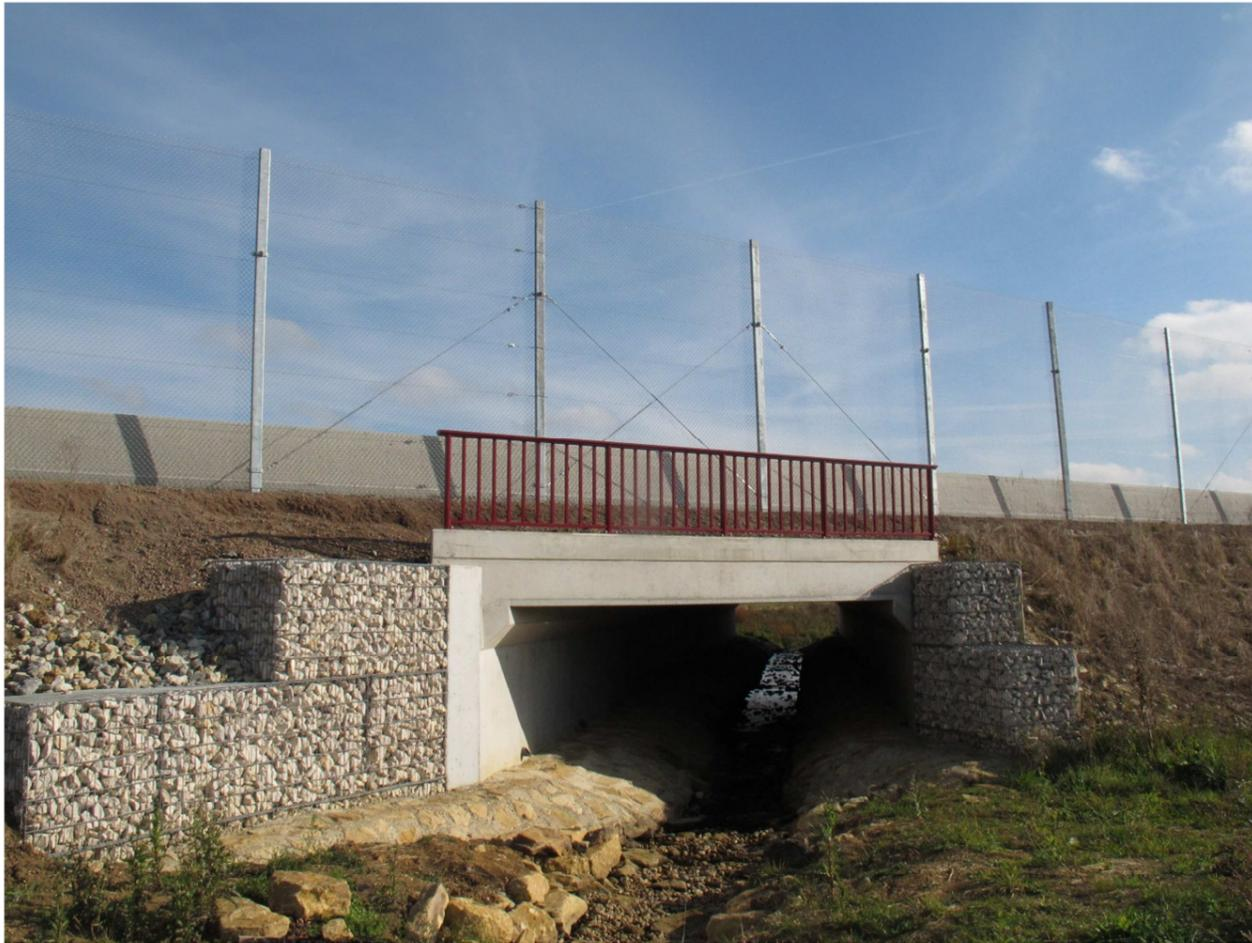
Figure 15 : exemple de grillage et garde-corps (CD 57, photo CEREMA)
