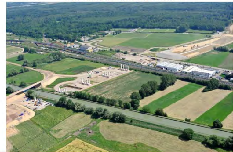
Viaduc de Vendenheim
