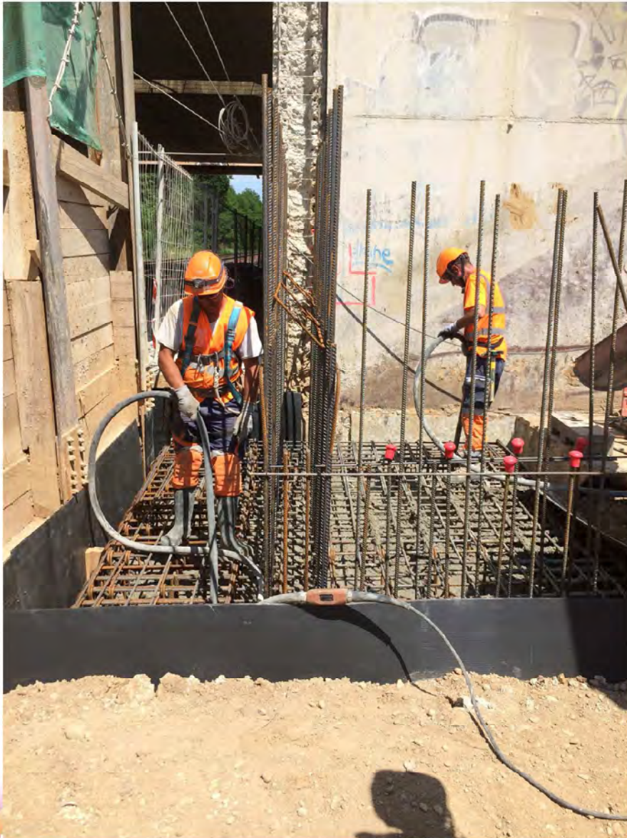
Premiers bétons pour les semelles de l'ouvrage
