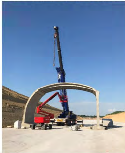
Tranchée Couverte de Vendenheim
