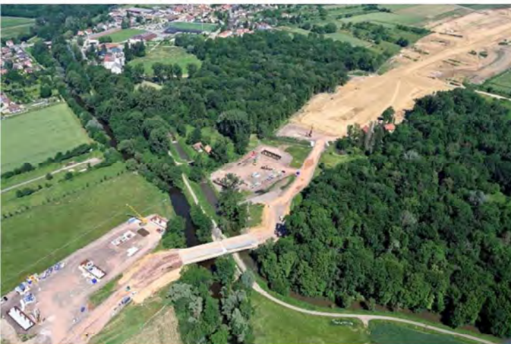
Viaduc de la Brûche
