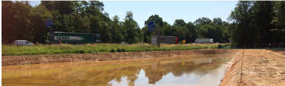
Creusement du bassin en cours
