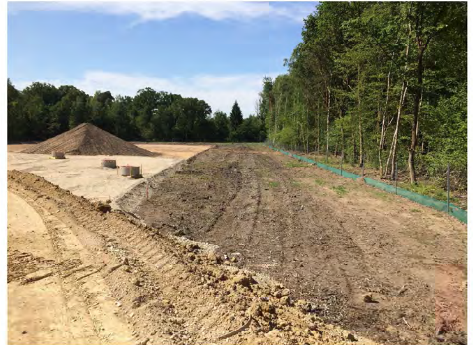
Montage du remblai de préchargement sur base drainante
