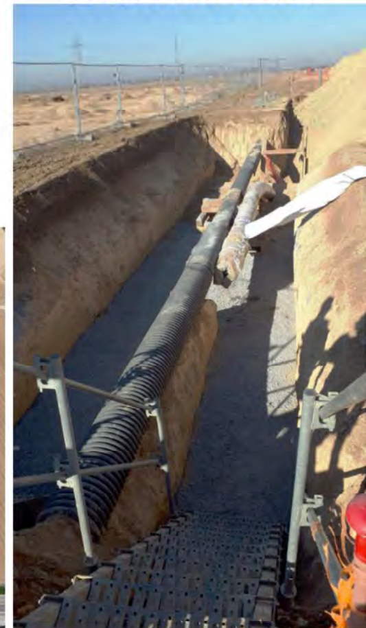
Déviation de réseaux
