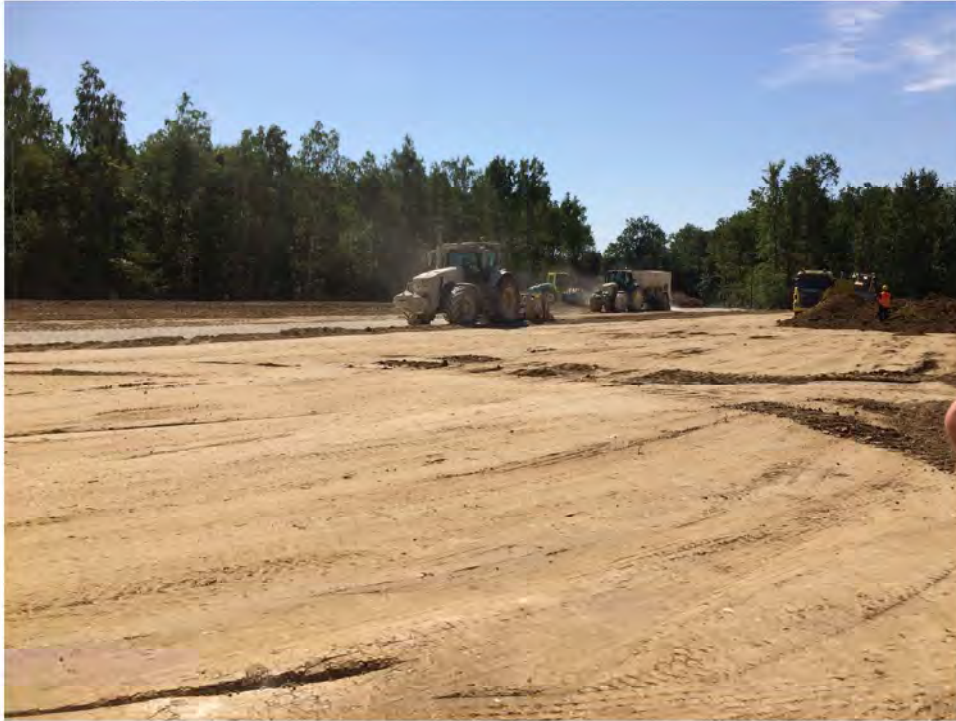
Montage du remblai de préchargement sur base drainante
