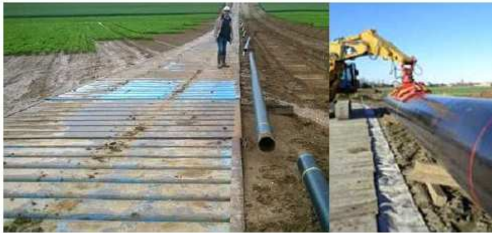
Figure 102 : Illustrations de pistes démontables de chantier en plats-bords
