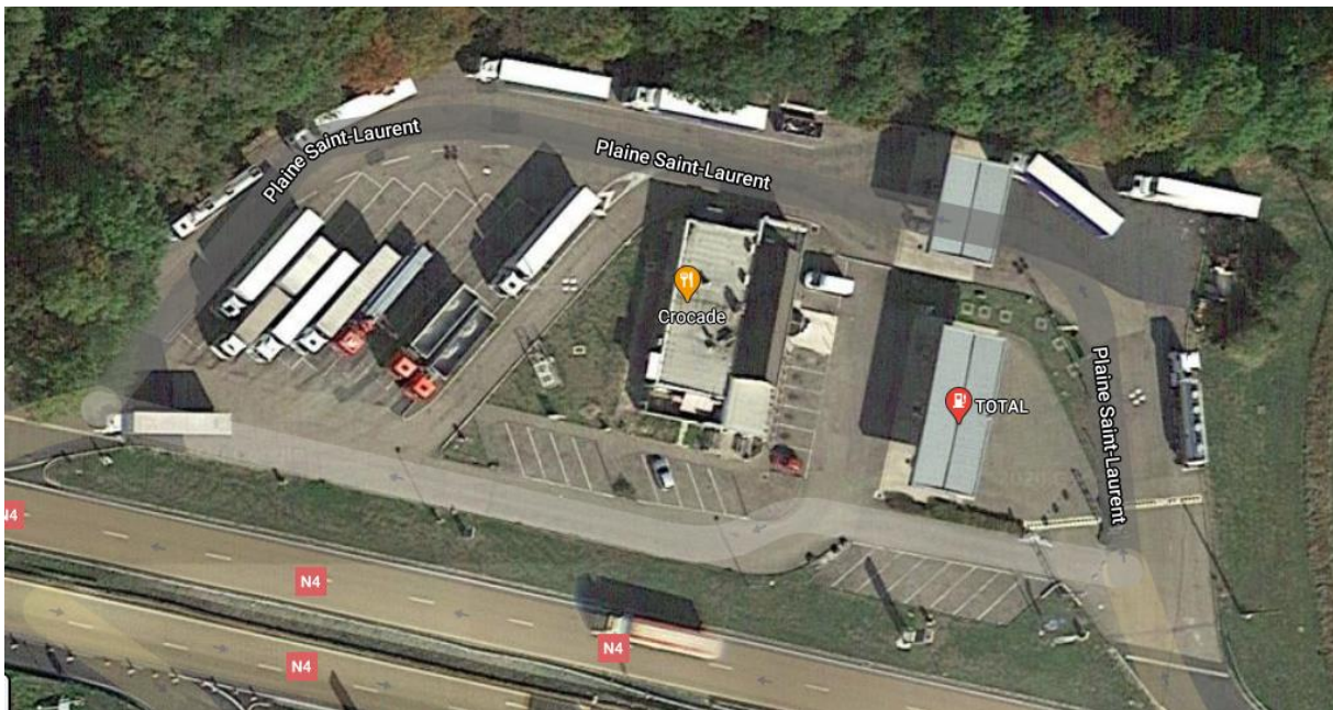
Vue aérienne zoomée de la station-service Total relais du Der Nord
