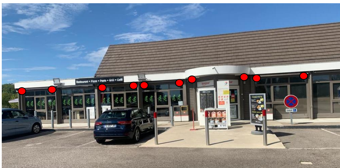
Localisation des nids d'Hirondelle rustique sur la façade (les nids étant symbolisés par les ronds rouge)
