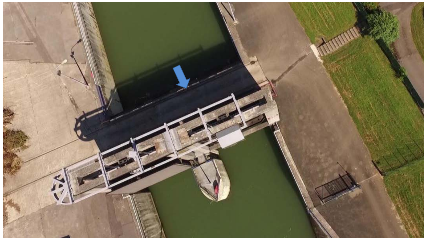
Figure 33: Prise d'eau du lac-Réservoir Marne
