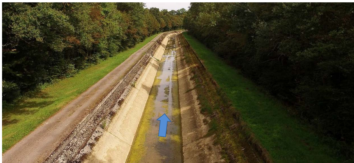
Figure 39: Canal situé à l'extrémité du canal d'amenée Blaise
