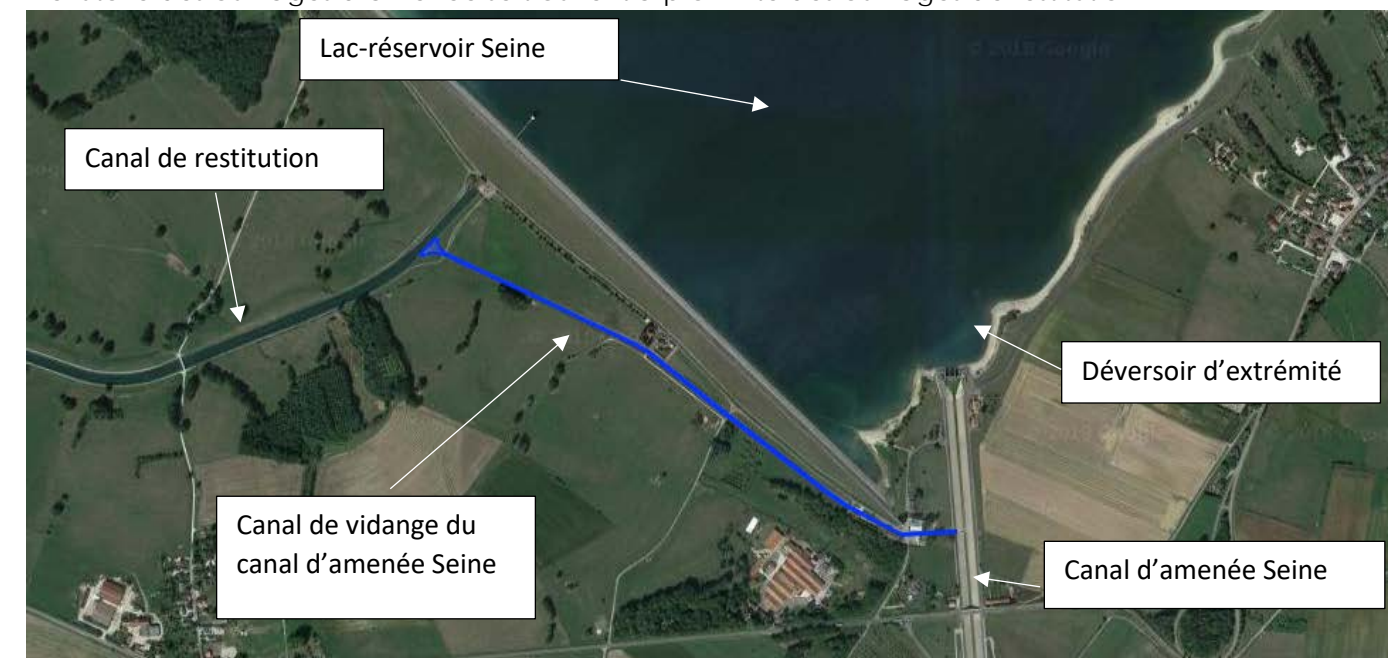
Figure 7: Localisation du canal de vidange du canal d'aménée Seine
