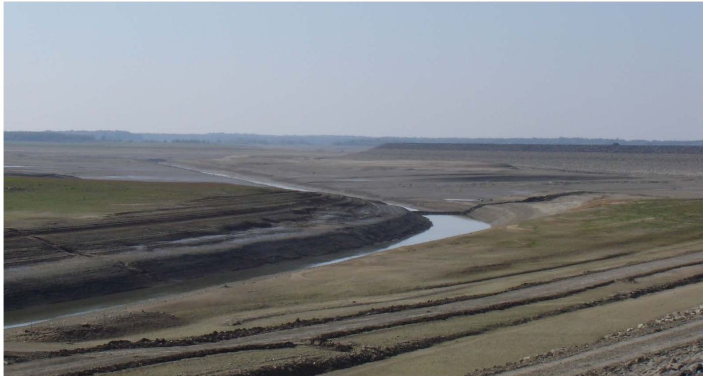
Figure 19: Tranchée de communication du lac-réservoir Auzon-Temple
