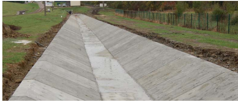
Figure 8: Organe de vidange du Canal d'amenée Seine
