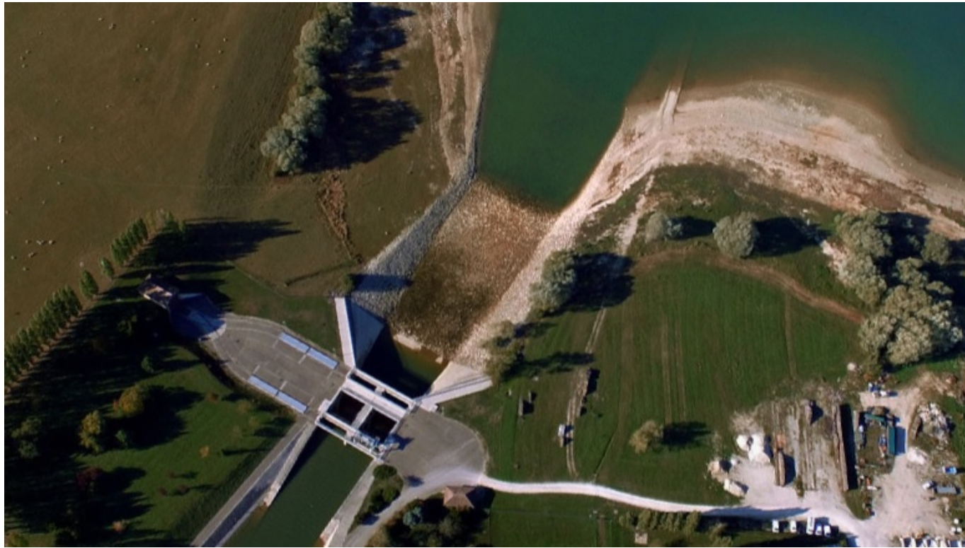
Figure 22: Chenal d'extrémité prolongé par des enrochements
