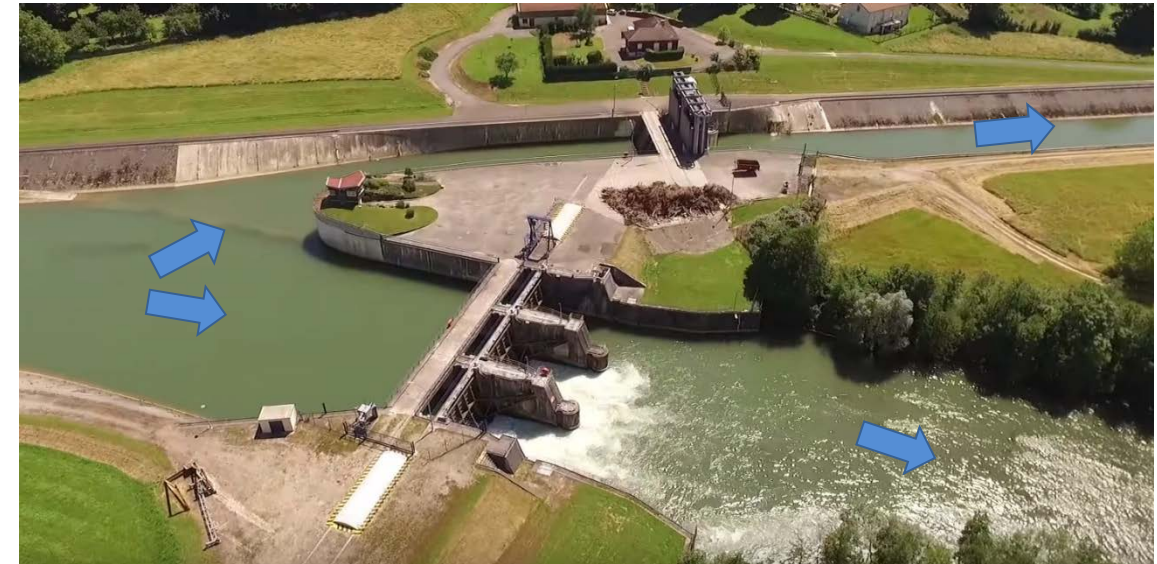
Figure 31: Barrage et Prise d'eau du lac-Réservoir Marne
