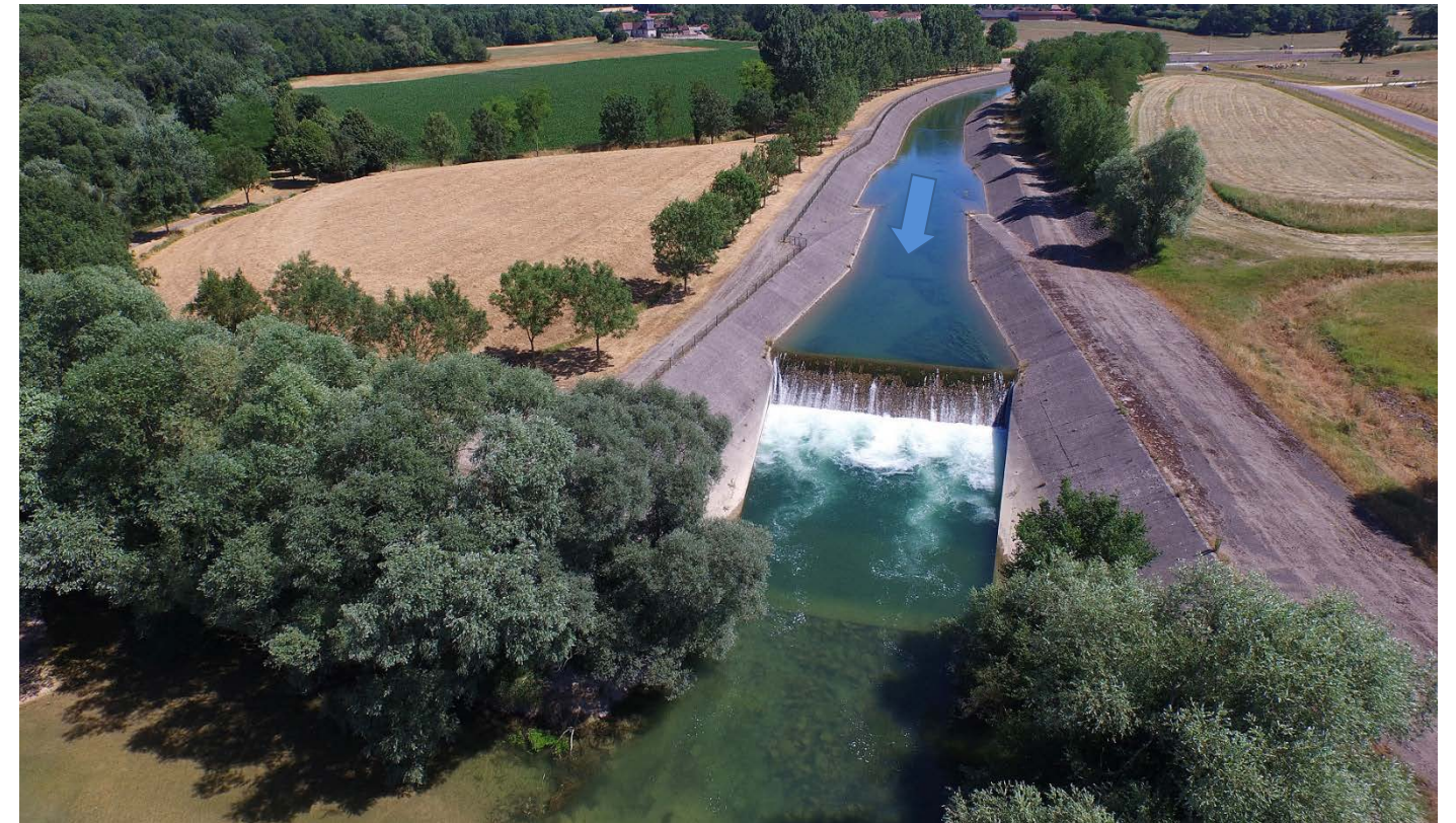
Figure 29: Déversoir d'extrémité du canal de restitution
