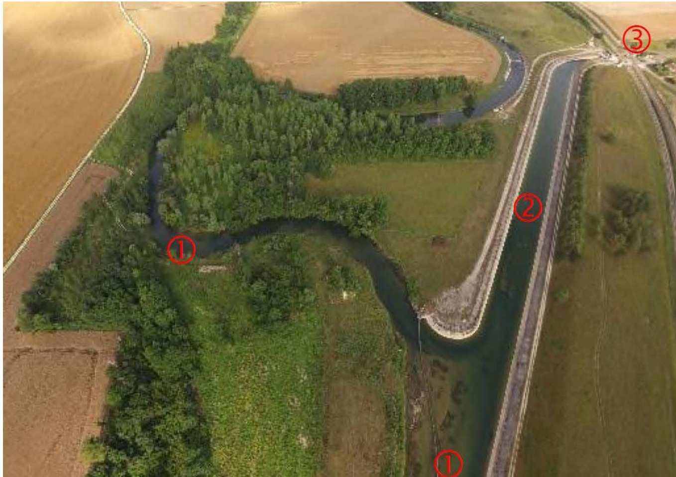
Figure 3: Vue générale par drone de la Prise en Seine
