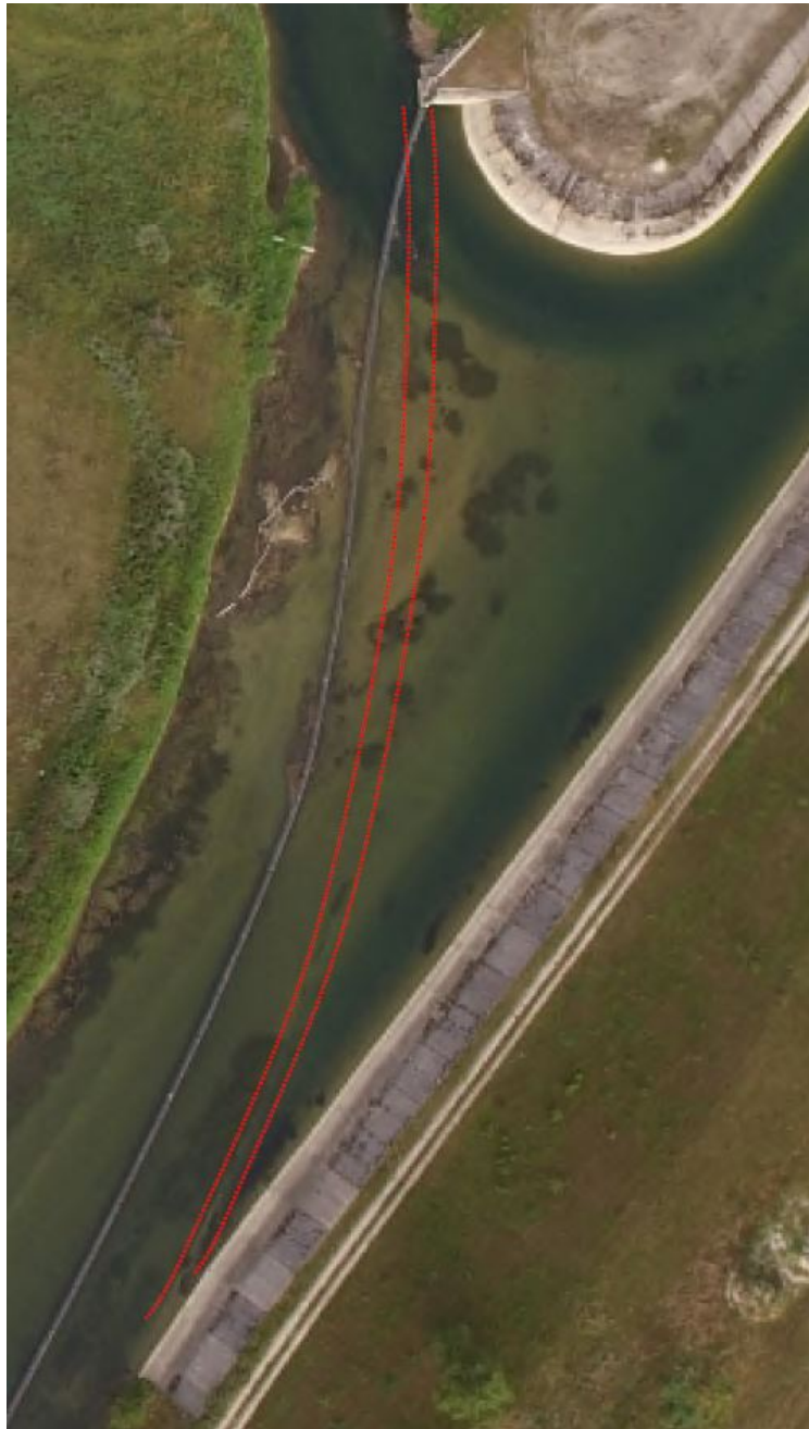
Figure 5: Matérialisation du muret (seuil de déversement) de la Prise en Seine
