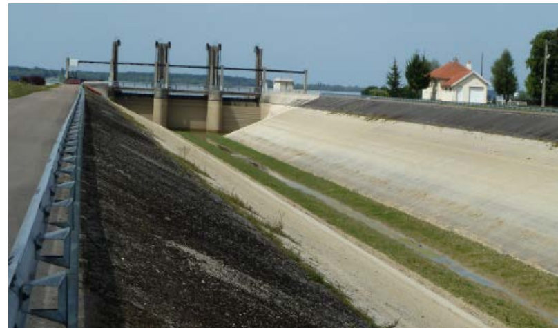
Figure 9: Déversoir d'extrémité du canal d'amenée Seine (vidangé)
