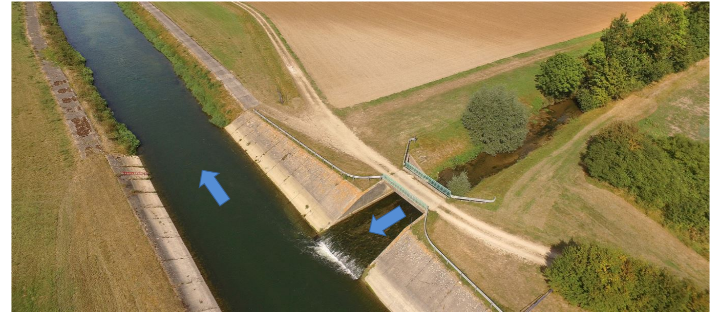
Figure 50: Bras de la Blaise se déversant par un seuil à 250m en aval du débouché en Marne
